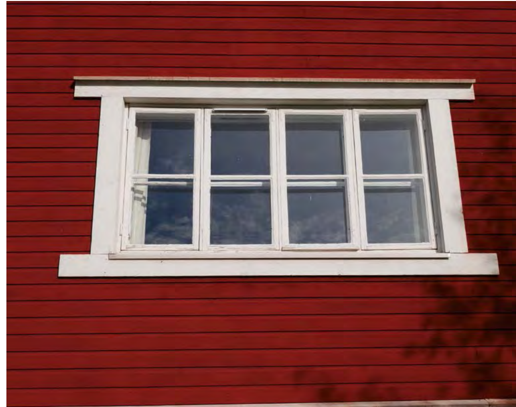
Säilynet ikkunat, uusitut vuorilaudat.
