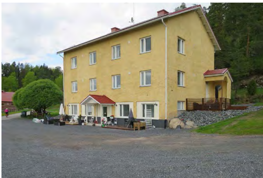
Näkymä kaakosta, maantasokerroksen autotallit on myöhemmin muutettu asuintiloiksi. Eteläpuolella on laaja sorakenttä.
