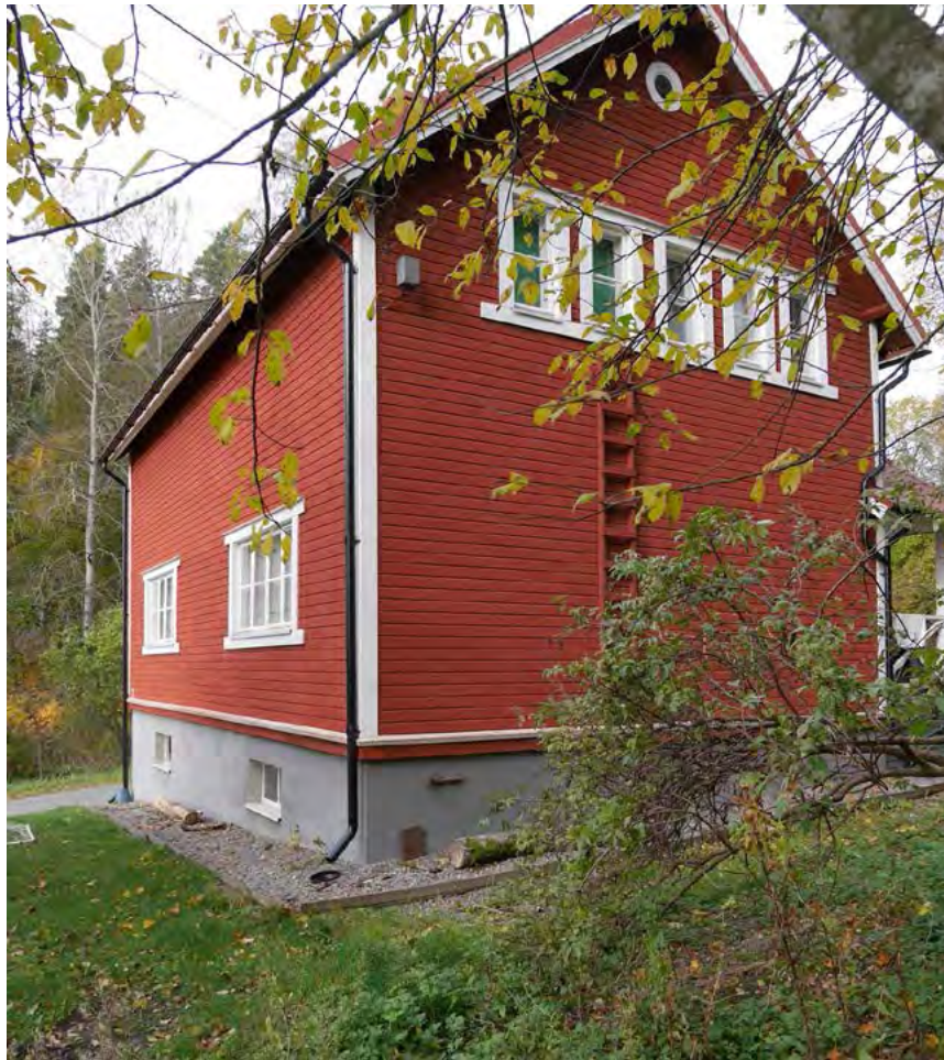
Itäpääty. Korjauksen yhteydessä on lisätty räystäskourut, syökytorvet ja rännikaivot.
