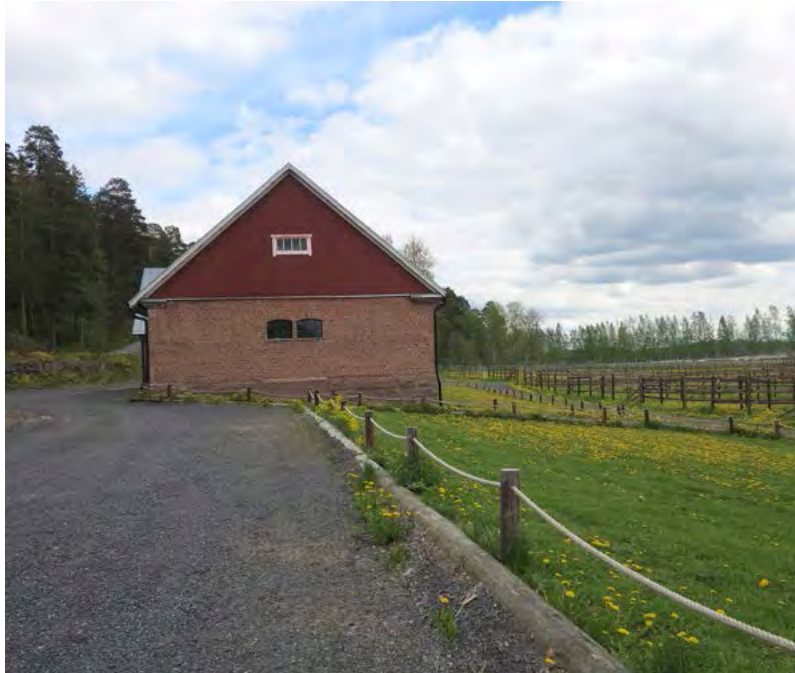
Maastoprofiilia on muokattu rakennuksen seinustalla.
