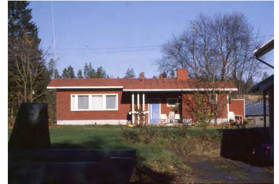
Kuva v. 1999, Teija Mäkelä. Rakennuksen ulkoasu on pääosin säilynyt alkuperäisenä n. vuoteen 2000.
