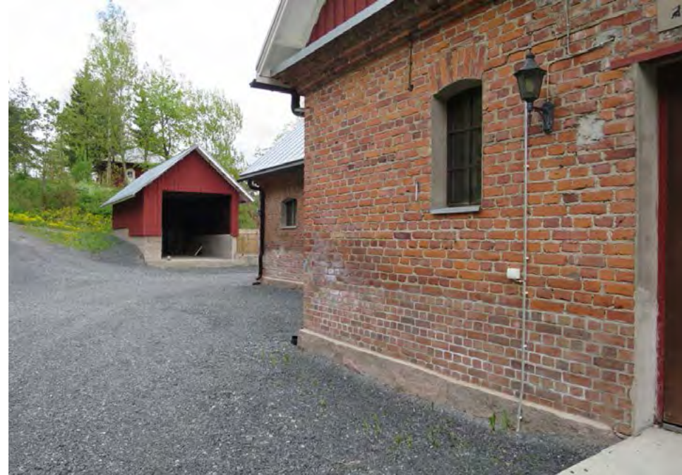
Rakennuksen ulkokuori on säilynyt j sitä on korjattu, sisäpuolinen rakenteellinen uudistus on ollut perusteellinen.
