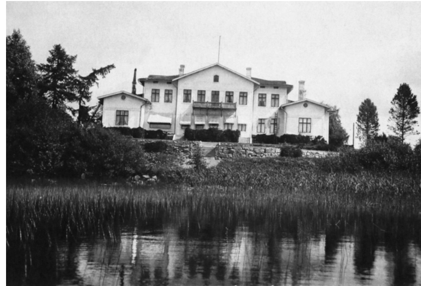
Järven puolelle rakennettu terassimuuri muodostaa jalustan Hjalmar Linderin aikana uudistetulle päärakennukselle. HyKM
