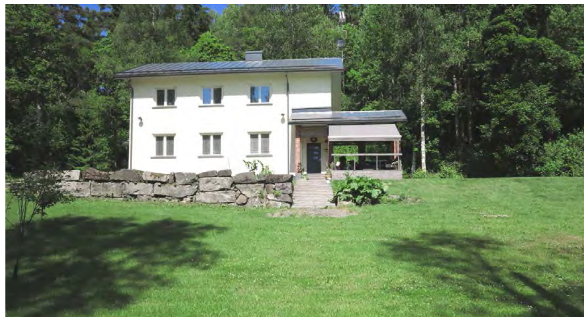
1940-luvulla rakennettu Kukkulinna. Tukimuuri talon edustalla on myöhempi lisäys.
