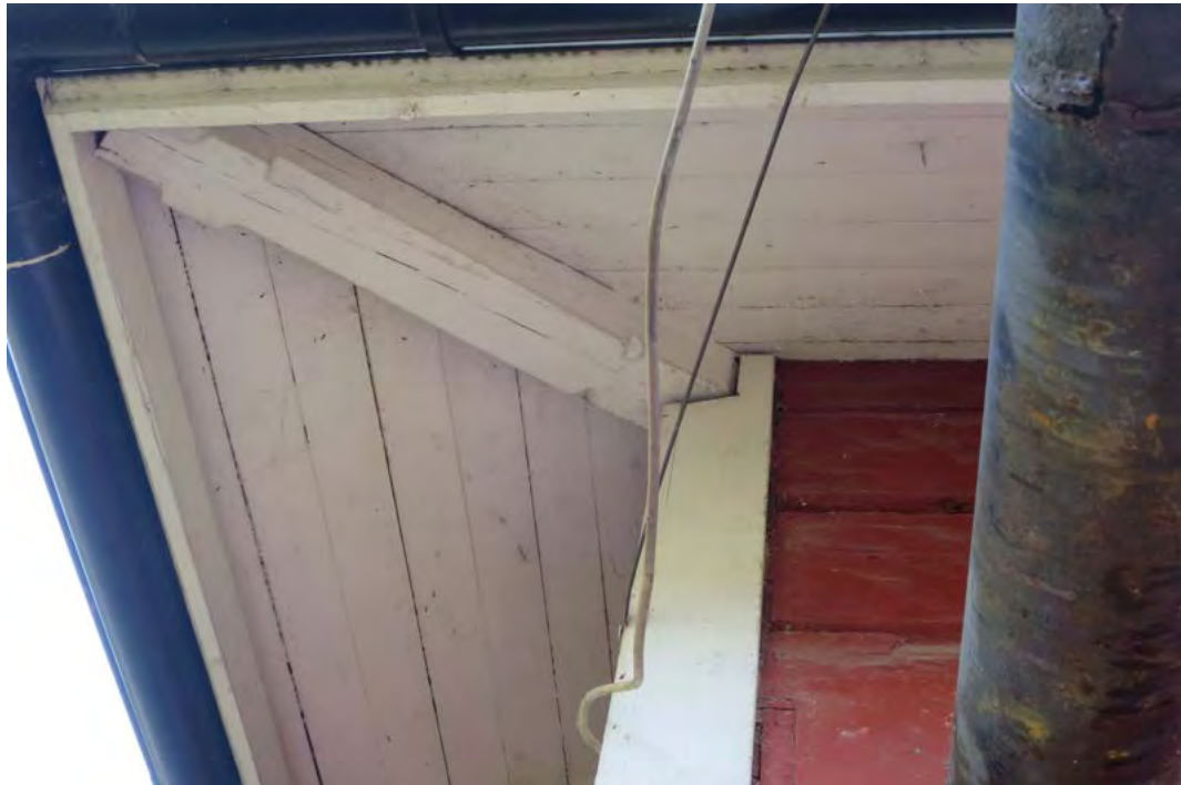
Puuleikkauksin veistetty räystäskannattaja on 1800-1900-luvun vaihteen puuarkkitehtuurille ominainen piirre.
