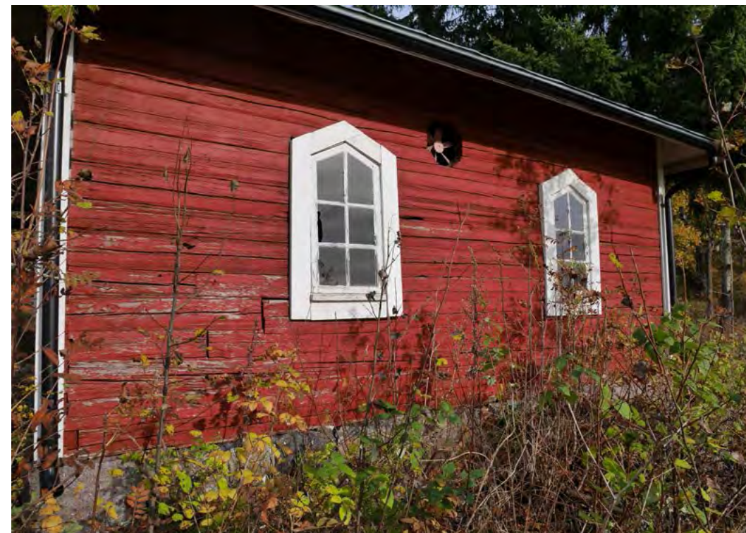
Kiviharkkosokkelille perustettu, käsin piilotettu hirsirunko.
