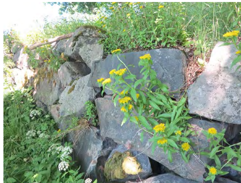
Rannan tukimuuri saunan eteläpuolella
