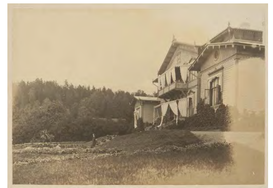
Päärakennuksen länsipuolelle rakennettiin järvinäkymälle avautuva pengerrys. Kuva 1800-luvun lopulta. Finna
