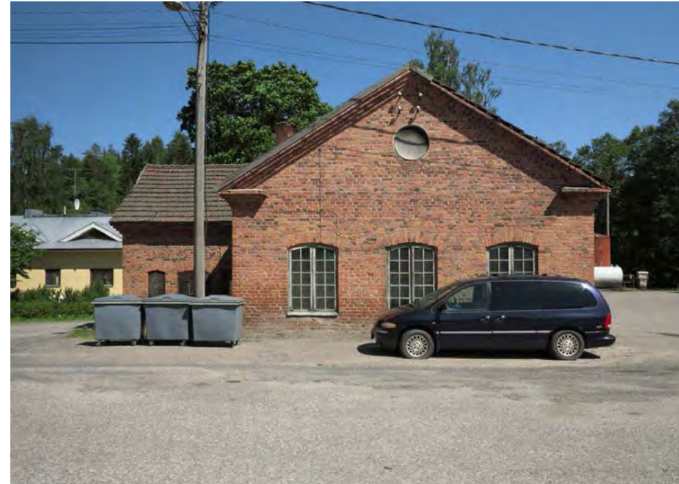
Ikkuna-aukkojen päällä on segmenttiholvi, samoin matalan siiven oviaukon päällä.
