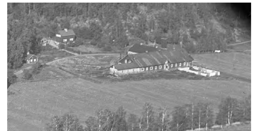
Pohjaltaan L-muotoinen navetta ilmakuvassa vuodelta 1938/ Sotamuseon arkisto. Itä-länsisuuntainen siipi on myöhemmin purettu ja sen paikalla on nykyään maneesi.
