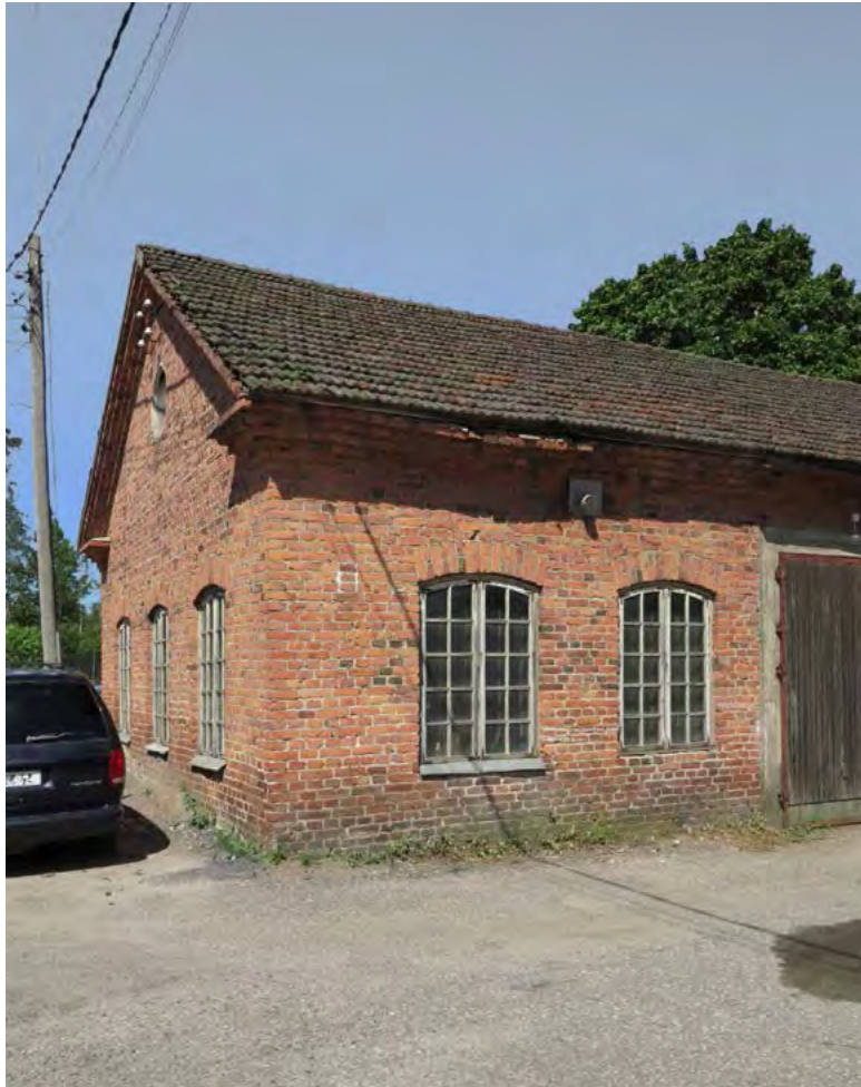
Ikkuna-aukkojen päällä on segmenttiholvi, samoin matalan siiven oviaukon päällä.
