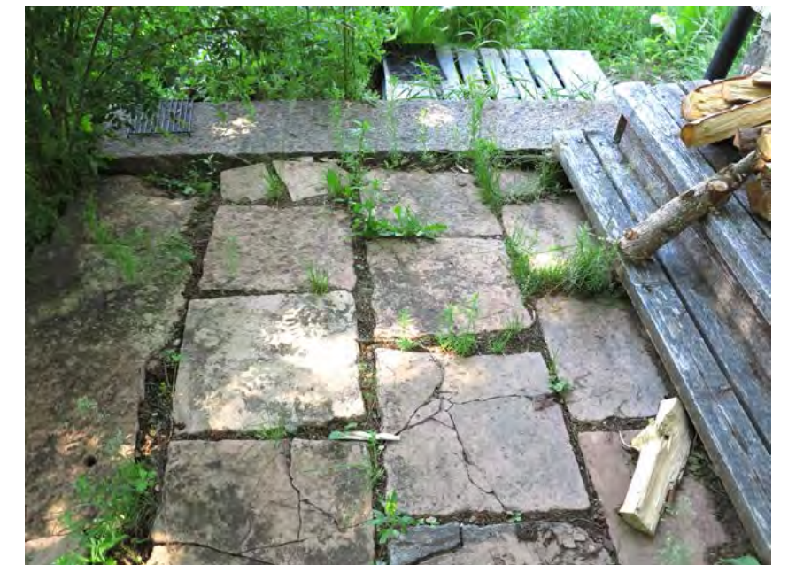
Pihaterassin kivi- ja puurakenteita.
