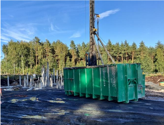
Laskeutuskontti rakennustyömaalla. (Kuva: Silja Suominen, Hyvinkään kaupunki).
