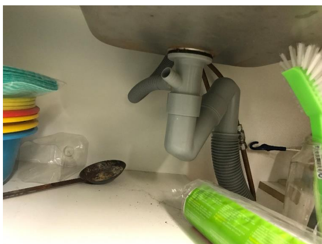
Allaskaappien viemäriiitokset on tarkistettava ja vuodonilmaus tulisi lisätä
