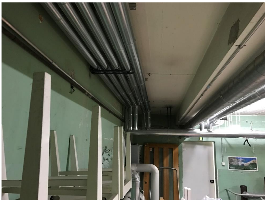
Putkistot on uusittu
