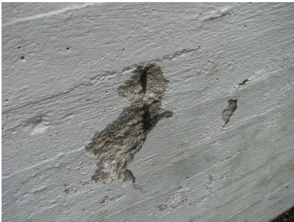
Perusmuurin teräkset tarvitsevat suojausta
