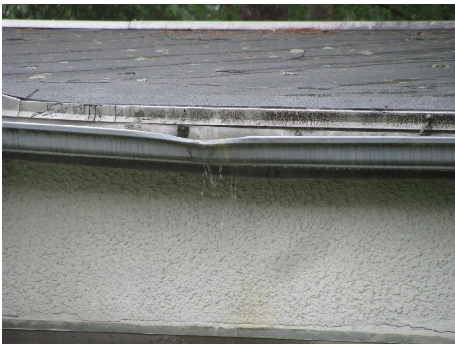
Kourut on oikaistava ja kallistettava riittävästi
