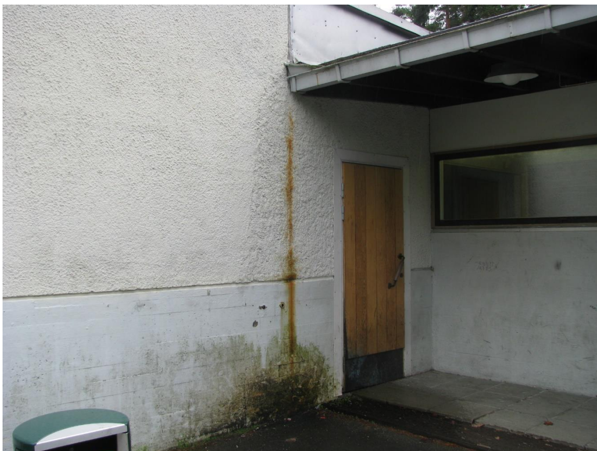
Kourujen vedenohjaukset tulee korjata
