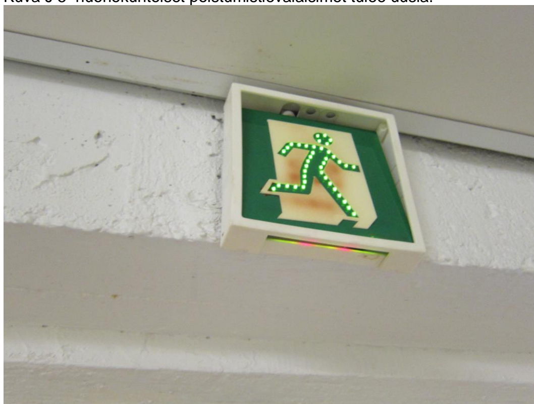
Kuva J 5 huonokuntoiset poistumistievalaisimet tulee uusia.
