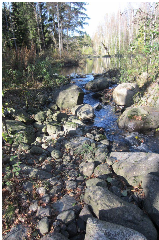
Kuva 11 Tekolammen pato on poistettu ja paikalle on rakennettu kalatie. AL
