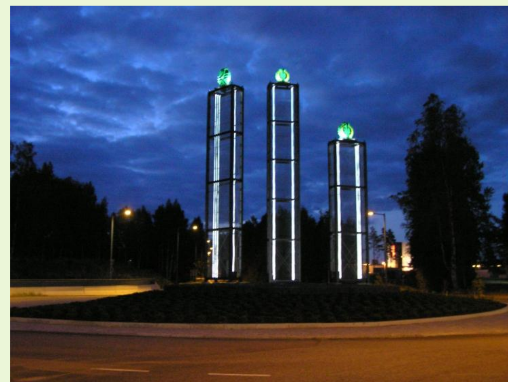
Helletorpan kiertoliittymän ”hissitornien” kaapelit on valaistu pimeään aikaan.
