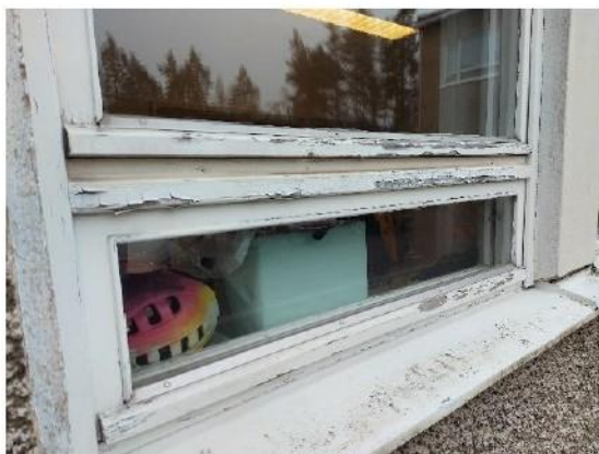
Kuva 3. Maalipinnan hilseilyä.
