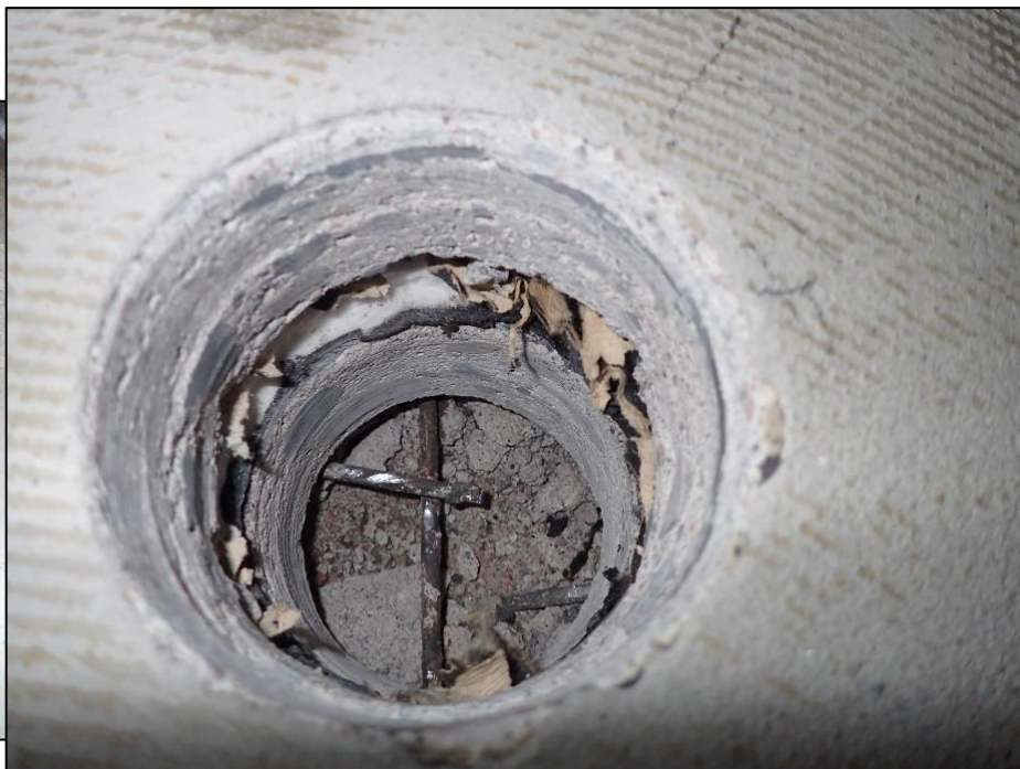
Kuvat 5 ja 6. Luokan 14 alapohjarakenteen rakenneavaus, RA5. Rakennauksessa ei todettu aistinvaraisesti arvioituna poikkeavaa.
