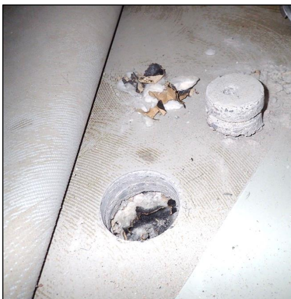
Kuvat 5 ja 6. Luokan 14 alapohjarakenteen rakenneavaus, RA5. Rakennauksessa ei todettu aistinvaraisesti arvioituna poikkeavaa.
