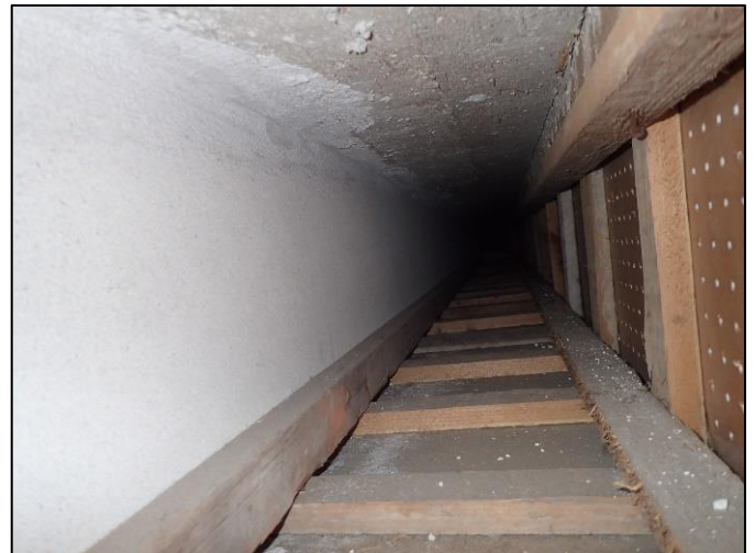
Kuvat 25 ja 26. Rakennuksessa on välipohjarakenteessa ilmanvaihdon rakennekanavia, jotka eivät enää ole käytössä. Kuvissa luokan 20 käytöstä poistettu tuloilmakanava.
