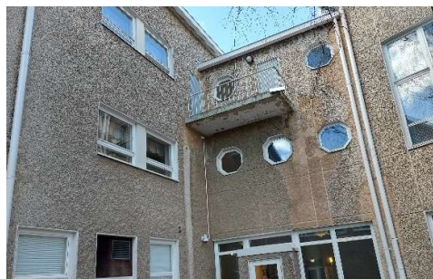
Kuva 16. Yleiskuva liikuntasalisiiven parvekkeesta.
