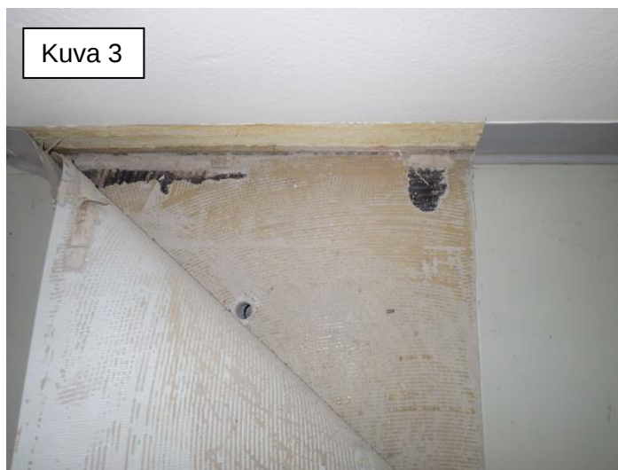
Kuva 1-3. Lattian vanhat vinyylilaatat (25 x 25 cm) ja/tai musta liima sisältävät asbestia. Musta liima on jätetty myös uudempien pintamateriaalien alle.
