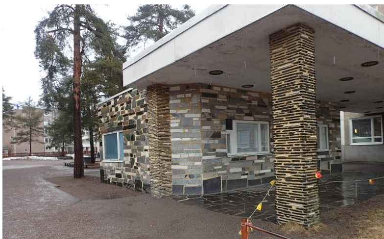
Kuvat 51, 52. Puhetti-kattoisen piharakennuksen julkisivut on laatoitettu luonnon kivillä. Katoksen alla ikkunarakenteet ovat hyvässä kunnossa, mutta säärasituksessa olevan ikkunan ulkopuitteet ja karmit ovat huonokuntoisia.
