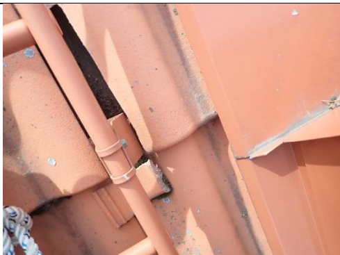
Kuva 41. Rikkinäinen tiililaatta.
