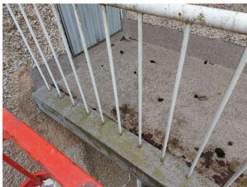
Kuva 17. Liikuntasalisiiven parvekkeen yläpinnassa on ehjä akryylipinnoite ja riittävät ylösnostot.
