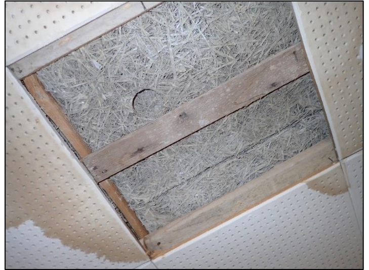
Kuvat 23 ja 24. 2. kerroksen käytävän katossa luokan 27 lähellä on vanha vesivuotojälki. Rakenne avattiin ja näytteet mikrobialalyysiin otettiin haltex-levystä (MR4) ja lastuvillalevystä (MR3). Näytteissä ei todettu mikrobikasvustoa.
