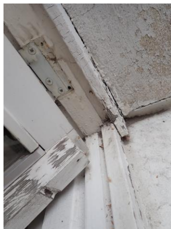
Kuva 14. Saranan paikkaa vaihdettu.
