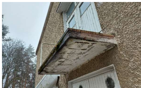
Kuva 15. Yleiskuva käsityötilojen parvekkeesta rakennuksen päädyssä.
