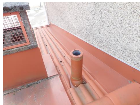
Kuva 48. Viemärin tuuletusputkien läpivientikohta on tehty mallikkaasti.
