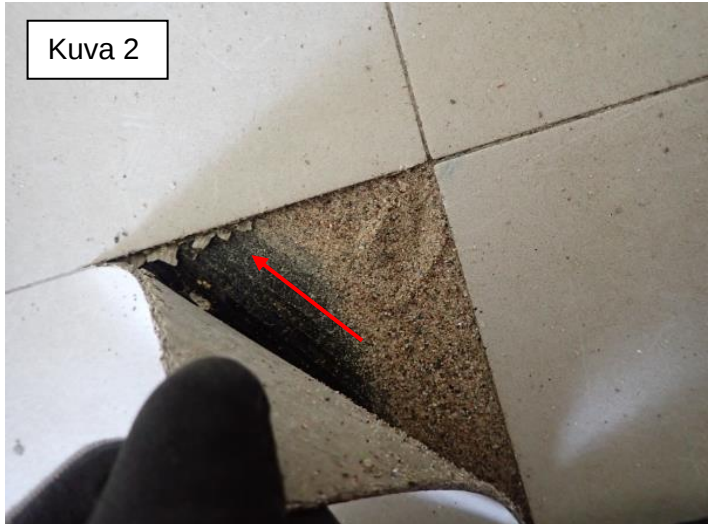
Kuva 1-3. Lattian vanhat vinyylilaatat (25 x 25 cm) ja/tai musta liima sisältävät asbestia. Musta liima on jätetty myös uudempien pintamateriaalien alle.
