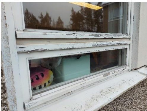
Kuva 3. Maalipinnan hilseilyä.
