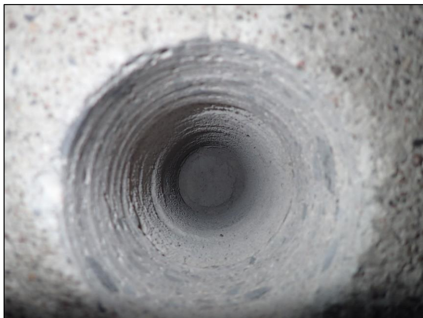
Kuvat 33 ja 34. Ullakon (puukäsityöluokan yläpohjan) lattian rakennearaus. Palpermantona n. 70 mm:n betonilaatta, jonka jälkeen on kevyt-betonia 250 mm ennen kantavaa teräsbetonista ylälaattapalkistoa.
