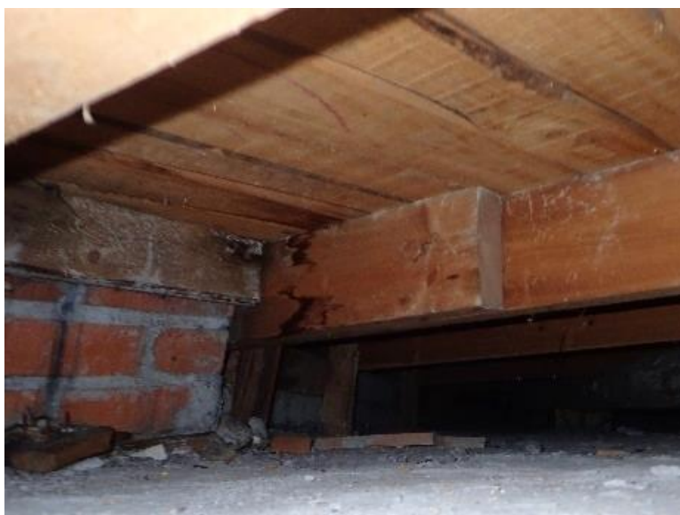
Kuvat 31 ja 32. Palpermannon päällä ja laudoituksessa havaittiin paikoin vanhoja vesivuotojälkiä ajalta ennen katteen uusimista. Vähäisiä vesivuotojälkiä on näkyvissä myös liikuntasaliosan yhden hormin kohdalla. Vesivuotojälkien kohdalla pintarakenteissa ei todettu poikkeavaa kosteutta.
