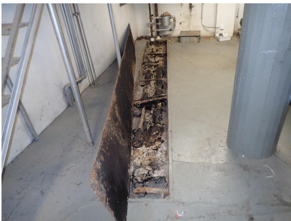
Kuva 7. Kellarikerroksen alapohjarakenteessa on muutamia kanaalirakenteita, joissa kulkee mm. vanhoja öljylämmitykseen käytettyjä putkia. Kuvassa kattilahuoneen lattian putkikanaali, jossa on joskus ollut öljyvuotoa. Mustuneissa putkieristeissä ei todettu haitta-aineita: asbestia tai PAH-yhdisteitä (erillinen AHA-raportti: Sweco Asiantuntijapalvelut Oy 14.5.2021).
