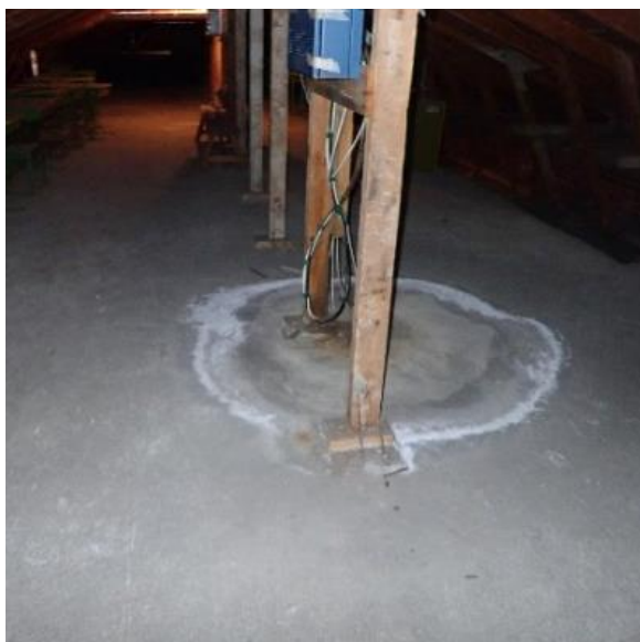
Kuvat 31 ja 32. Palpermannon päällä ja laudoituksessa havaittiin paikoin vanhoja vesivuotojälkiä ajalta ennen katteen uusimista. Vähäisiä vesivuotojälkiä on näkyvissä myös liikuntasaliosan yhden hormin kohdalla. Vesivuotojälkien kohdalla pintarakenteissa ei todettu poikkeavaa kosteutta.
