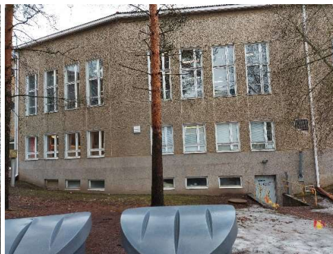
Kuva 4. Liikuntasalisiiven kohdalla runsaasti laattapintaista betonirakennetta
