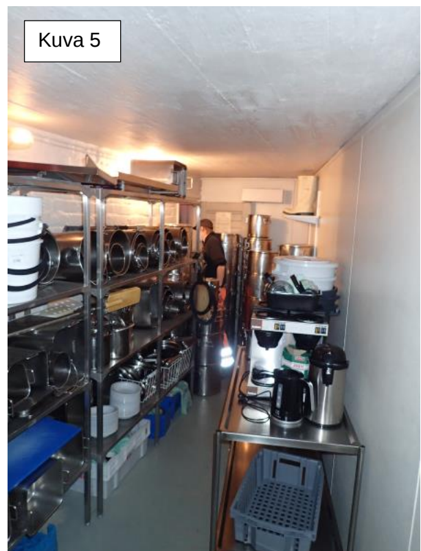
Kuvat 4-5. Kellarissa keittiön varastotilassa on lujalevyä seinien sisäverhouslevynä. Lujalevyä on lisäksi kellarin saunatilan seinässä ja kiukaan ympärillä. Lujalevy sisältää asbestia.
