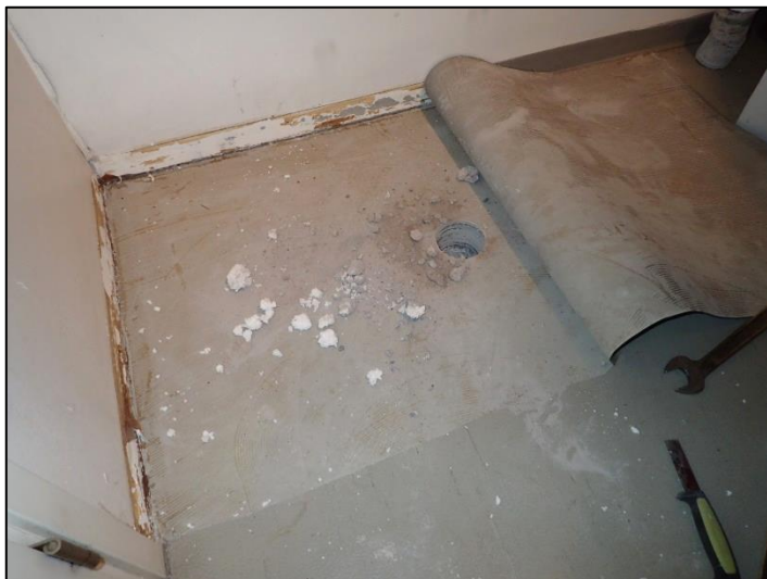
Kuvat 55 ja 56. Piharakennuksen teknisen tilan alapohjarakenteen rakenneavaus. Rakenneavauksessa muovimaton alla tai muissa materiaaleissa ei todettu poikkeavaa hajua, eikä pintarakenteissa todettu epäiltävää kosteutta. Rakenteen eristekerroksesta (styroksi) otettiin näyte (MR8) mikrobialalyysiin. Näytteessä ei todettu poikkeavaa mikrobikasvustoa.
