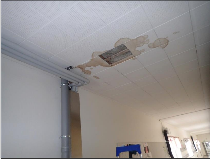
Kuvat 23 ja 24. 2. kerroksen käytävän katossa luokan 27 lähellä on vanha vesivuotojälki. Rakenne avattiin ja näytteet mikrobialalyysiin otettiin haltex-levystä (MR4) ja lastuvillalevystä (MR3). Näytteissä ei todettu mikrobikasvustoa.
