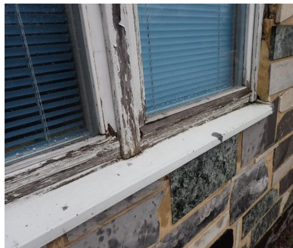
Kuvat 51, 52. Puhetti-kattoisen piharakennuksen julkisivut on laatoitettu luonnon kivillä. Katoksen alla ikkunarakenteet ovat hyvässä kunnossa, mutta säärasituksessa olevan ikkunan ulkopuitteet ja karmit ovat huonokuntoisia.
