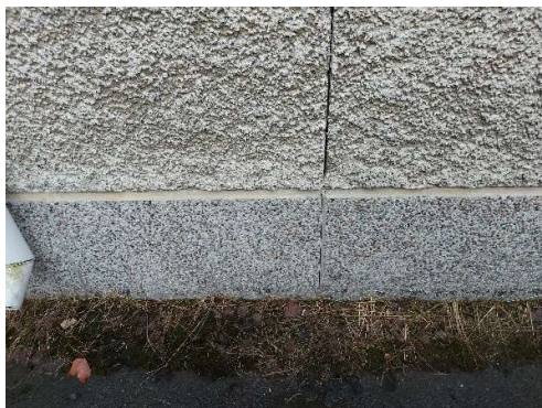
Kuva 3. Betonisen sokkelin pinnassa pesubetonipintainen laatta
