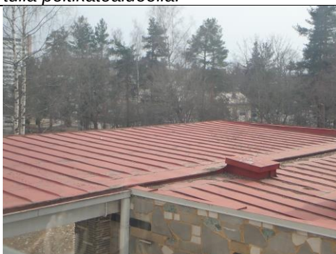
Kuva 49. Vanhan peltikatteen maalipinta hilseilee.
