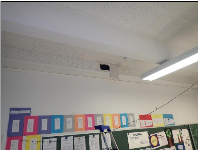
Kuvat 25 ja 26. Rakennuksessa on välipohjarakenteessa ilmanvaihdon rakennekanavia, jotka eivät enää ole käytössä. Kuvissa luokan 20 käytöstä poistettu tuloilmakanava.
