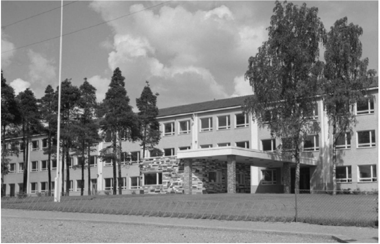
↑ Aseman koulun pääsisäänkäynti Ratakadun suunnalta. Kuva: Niilo Ristamo, 1955–1960, Hyvinkään kaupunginmuseo, Finna
