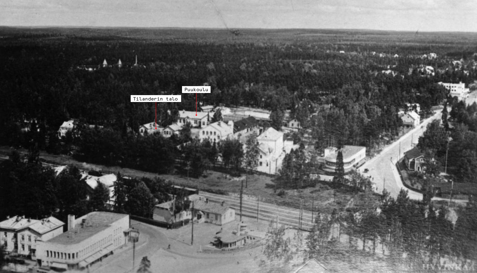
↑ Aseman koulun rakennus ja Tilanderin talo sitä vastapäätä hieman kuvan keskikohdasta vasemmal- le. Matalaa modernia rakentamista on noussut puutalojen rinnalle muutoin metsäiseen maisemaan. Kuva: Tuntematon kuvaaja, 1938–1939, Hyvinkään kaupunginmuseo, Finna
