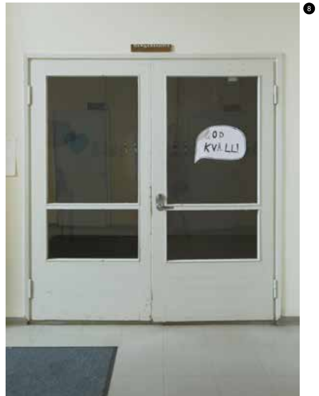
↑ Teknisen käsityön tiloihin johtava puulasiovi toisen kerroksen käytävällä.
