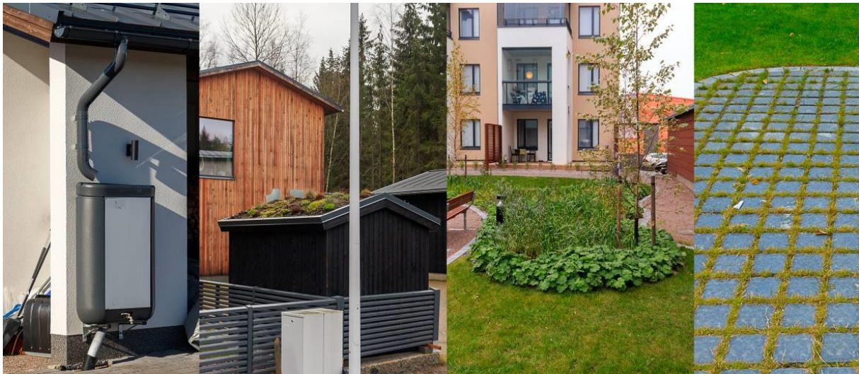
Kuva 7. Hulevesien käsittelyyn on monta ratkaisua. Tässä kuvasarjassa kattovesisäiliö, viherkatto, hulevesipainanne ja vihersaumattu kivetyks.
