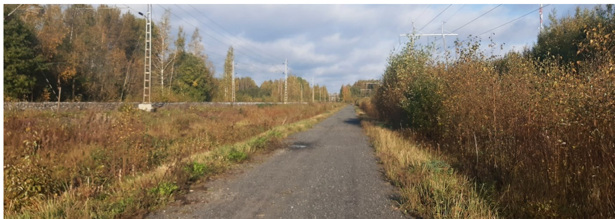
Kuva 9. Radan koillispuolta pohjoispäädystä. Kuvattu luoteeseen. Kuva: Johanna Rahtola, Maanala Oy.
