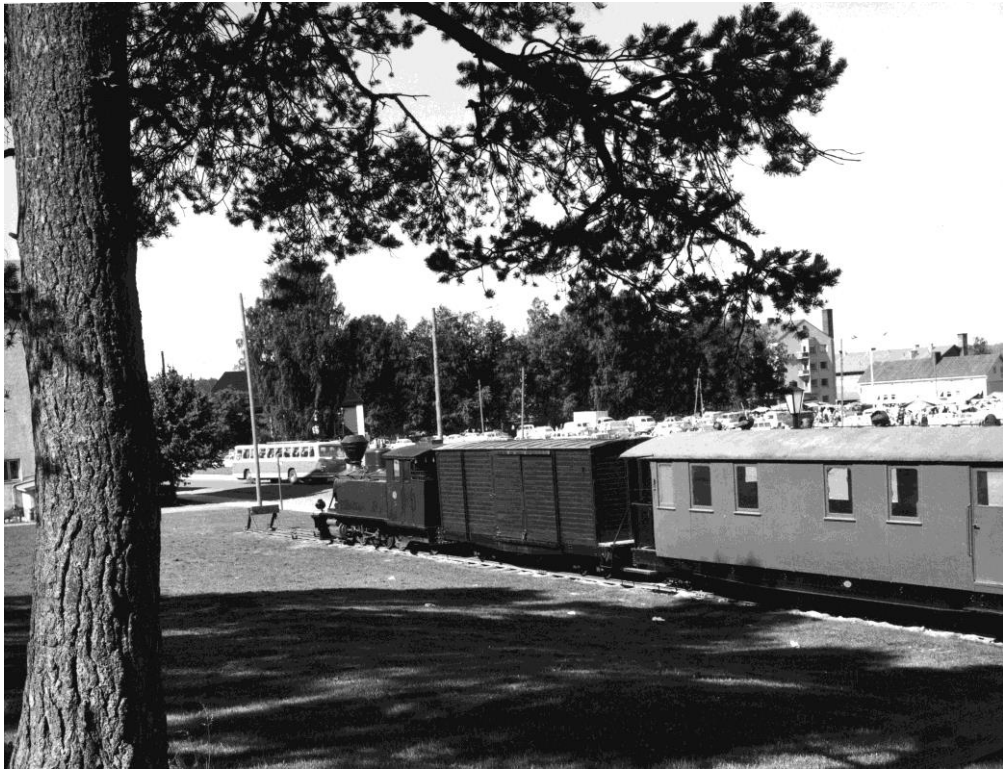
Kuva on otettu 8.8.1967 hiukan ennen liikenteen päättymistä. Eero Heinonsalo.
