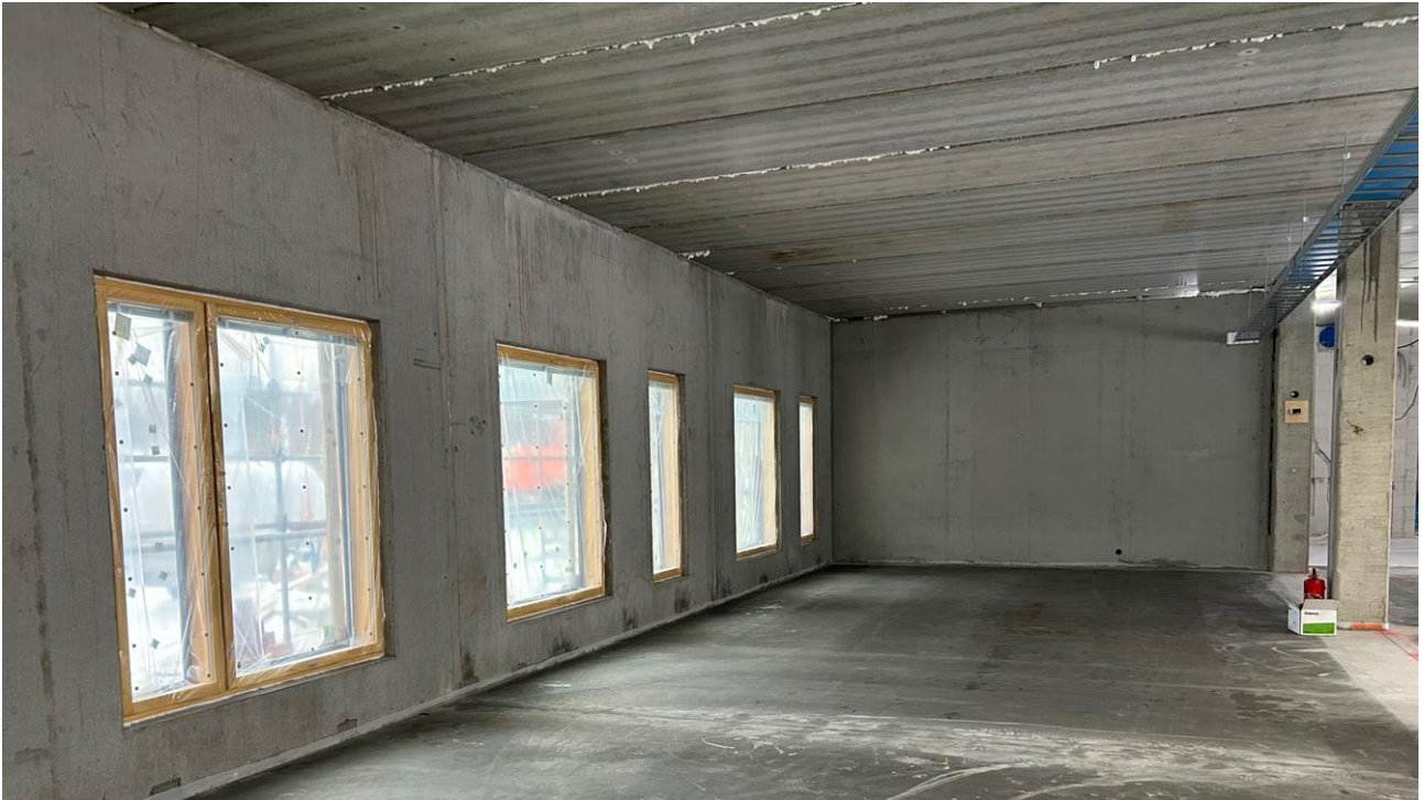
Ikkuna-asennus on käynnissä
