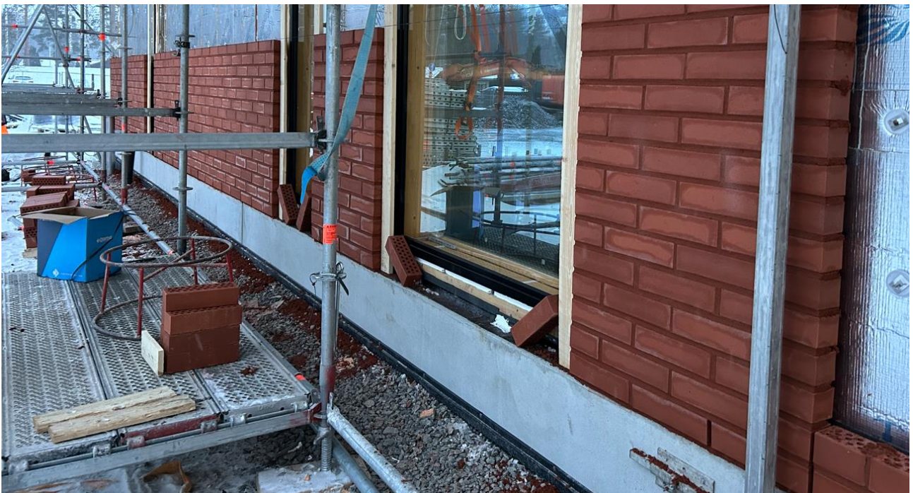
Julkisivun muuraustyöt on aloitettu
