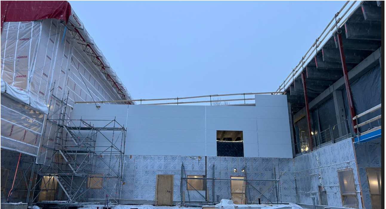
PVP- elementtiasennukset on aloitettu
