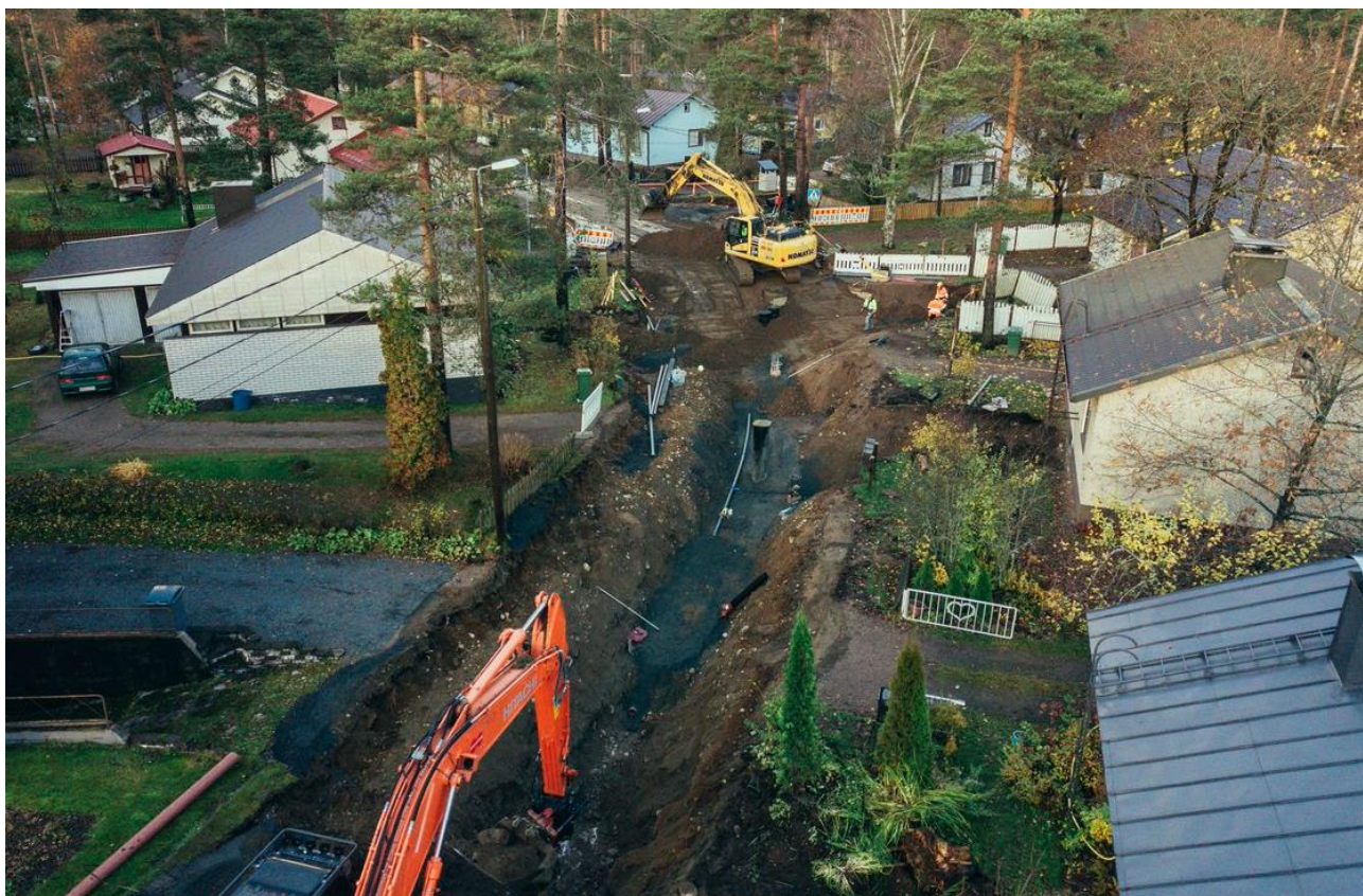
Sonninmäessä toteutettu vesiverkoston kunnostus oli Hyvinkään Veden historian suurin työ.
