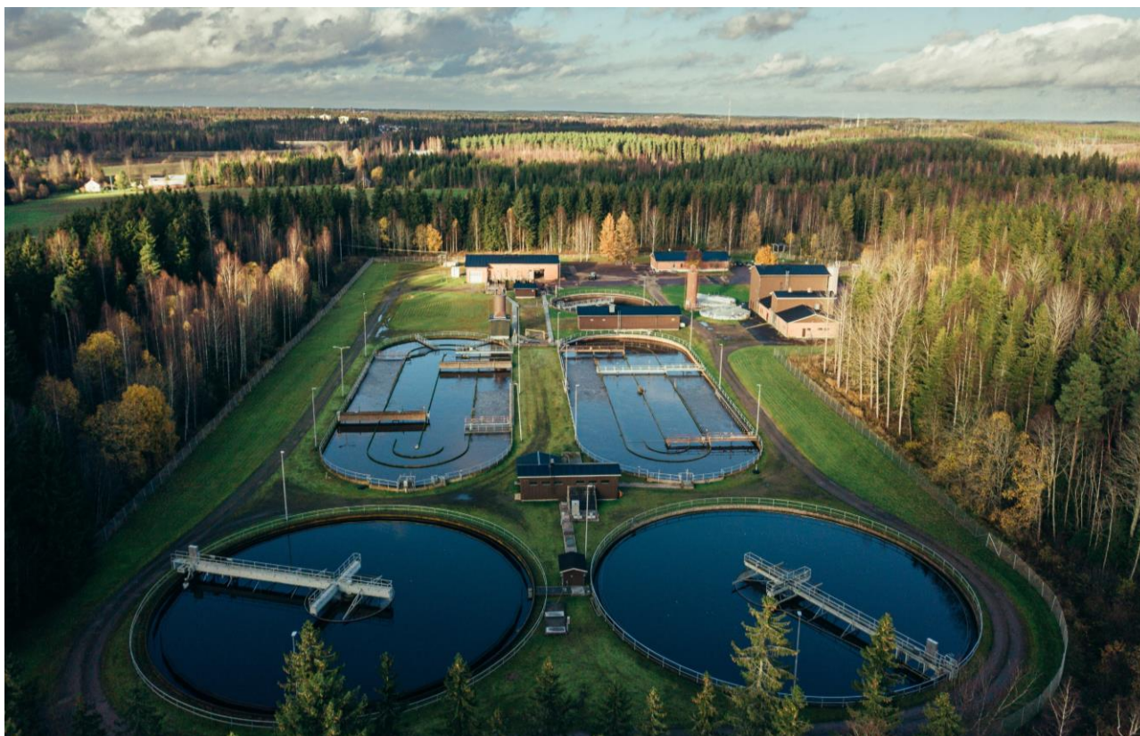
Kaltevan jäteveden puhdistamon kunnostuksen suunnittelun yhteydessä on suoritettu tarpeellinen riskiarvio, jotta tuleva saneeraus toteutuu turvallisesti. (kuva: Hyvinkään kaupunki)
