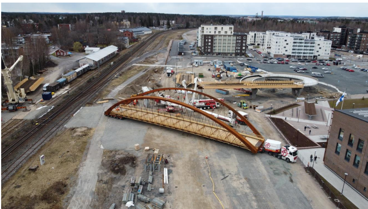
Vanhankirkonsilta tulee yhdistämään Hangonsillan alueen Uudenmaankatuun.
