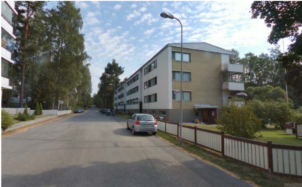
Kuva 2. Tontin 14 lamellikerrostalo Helenenkadun varressa.
