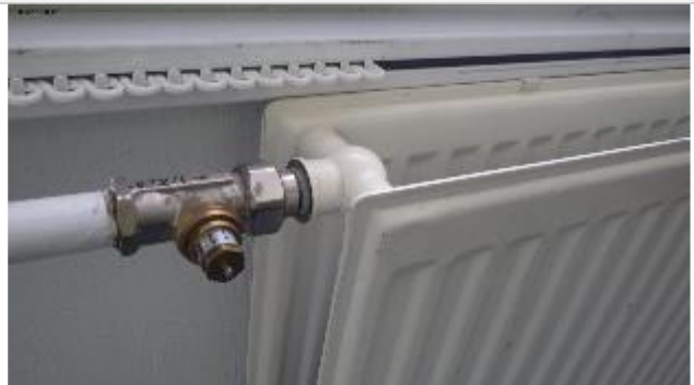
Yleiskuva lämmityspatterista, josta puuttuu termostaattinen patteriventtiili
