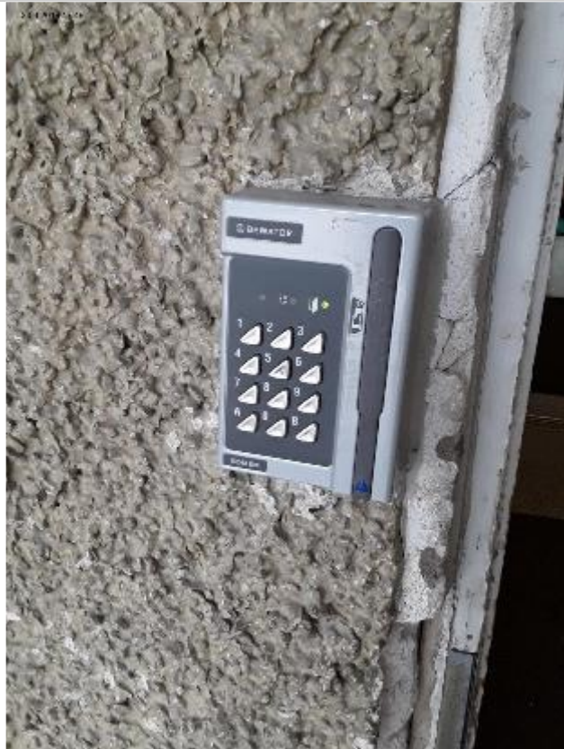
Ulko-ovien läheisyydessä on sähköiset ovilukitukset.
