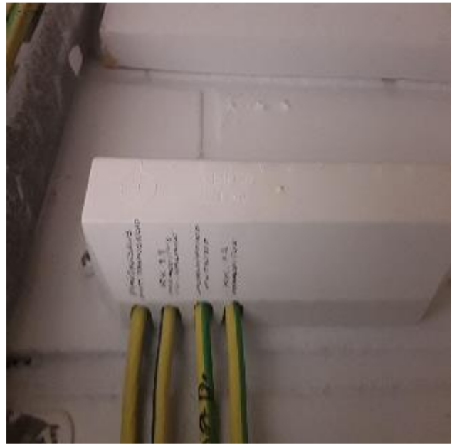
Jakelukeskuksien komeroissa tarpeen mukaan asennettu lisäpotentialintasauksia asianmukaisesti.
