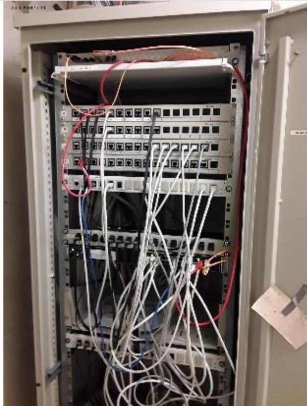
Päätelejakamo sijaitsee pääkeskushuoneessa.
