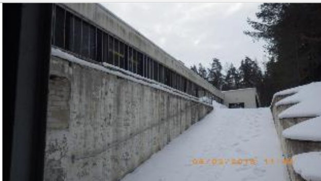
Kuva autotallin ajoluiskasta.
