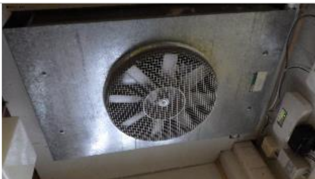
Yleiskuva lämmitysverkostoon kytketystä kiertoilmapuhallimesta, joka on Fläktin valmistama.
