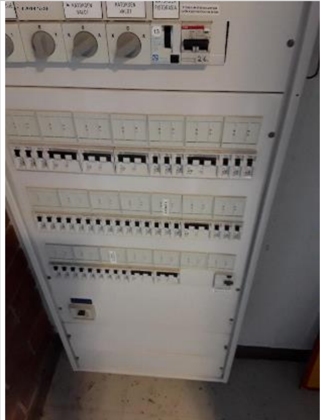
Keskukset ovat pääosin varustettu johdonsuoja-automaateilla.
