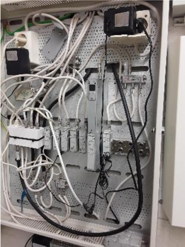
Antennivahvistin pääkeskushuoneessa. Keskukseen on tehty digimuutoksia.
