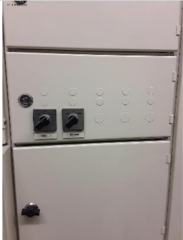
Pääkeskus on yhtenäinen kiinteistökeskuksen kanssa. Kytkimet ovat kannessa ja sulakkeet koteloiden sisällä.
