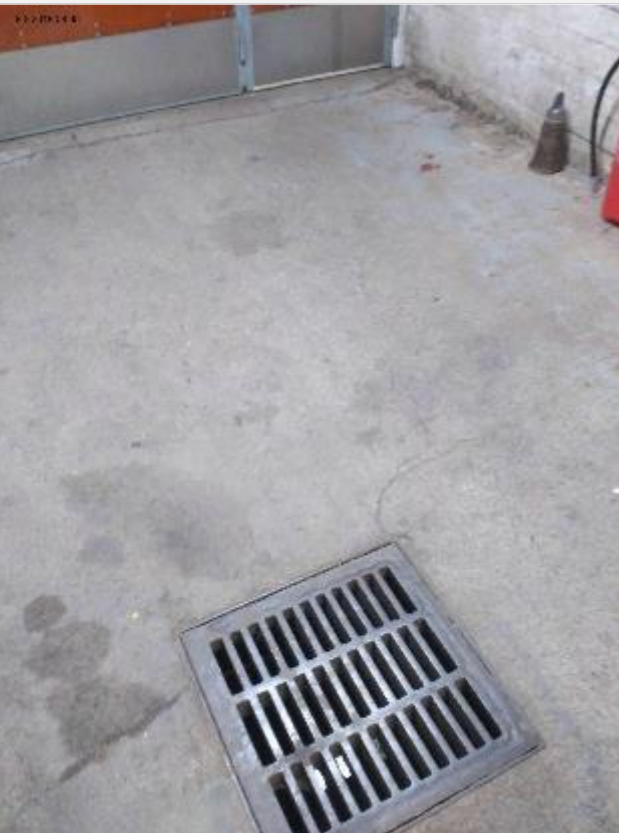
Autotallin lattian pinnoite on kulunut
