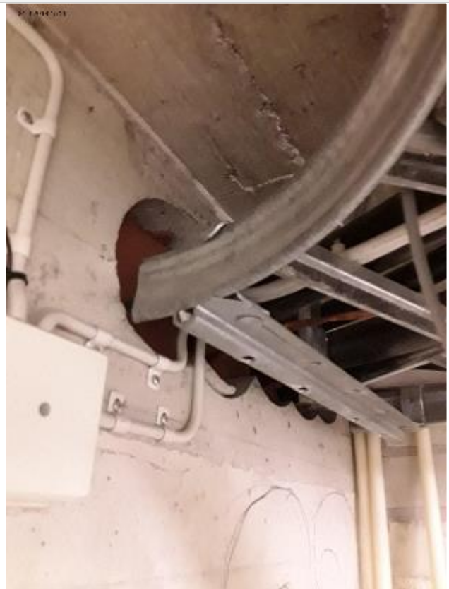
Pääkeskushuoneen tikashyllyn kohdalla on paloläpiviennit.
