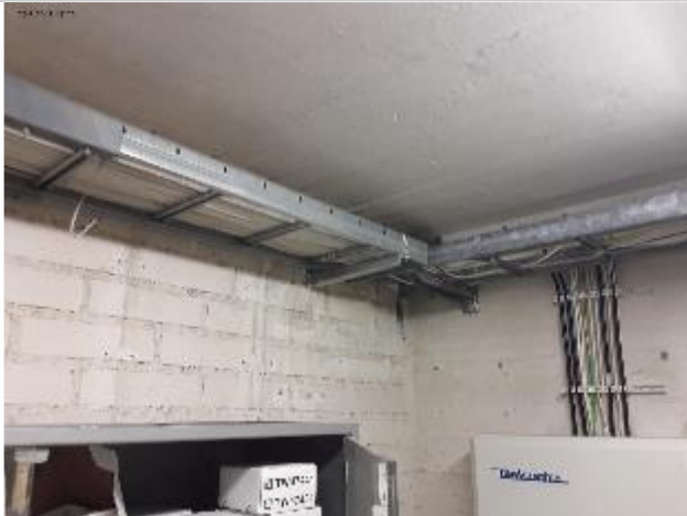
Tikashyllyjärjestelmä on pääosin hyvässä kunnossa.
