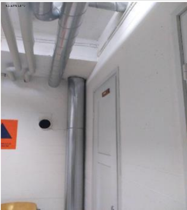
Kantavat rakenteet ovat betonirakenteita
