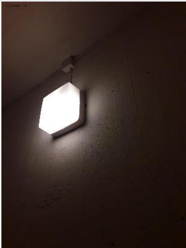
Kellaritiloissa on käytetty muovikuvullisia loiste- ja pienloistevalaisimia.
