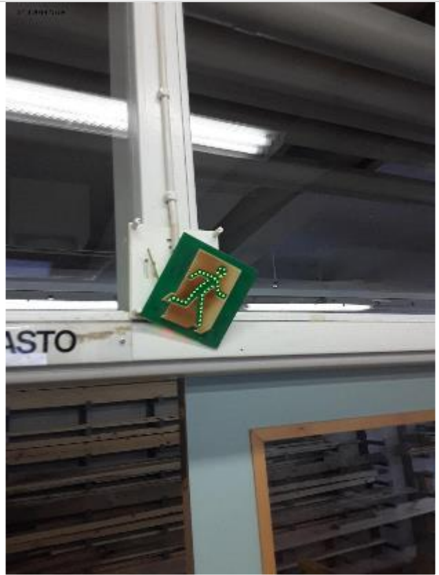
Puutyöluokan poistumistievalaisin on uusimisen tarpeessa.
