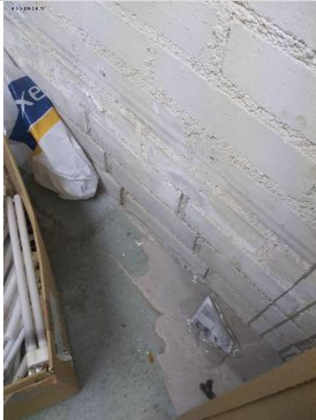
Kellarissa kiviainesrakenteisissa seinissä näkyy härmää ja pinnon irtoamista.
