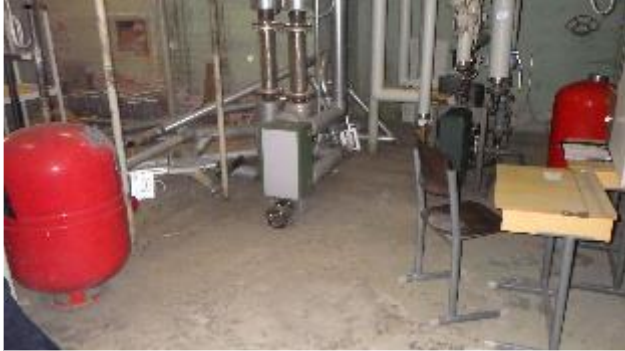
Yleiskuva kiinteistön kaukolämmönalajakokeskuksesta
