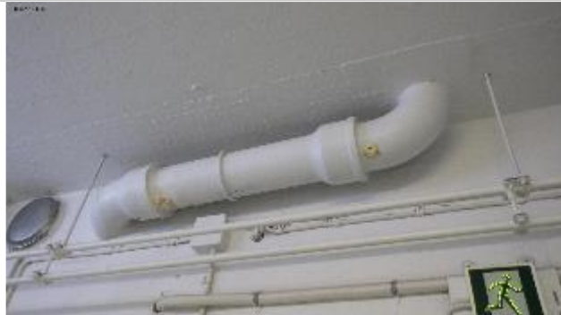
Kiinteistökerroksella havaittiin viemäreitä, joissa on syviä pistesyöpymiä.
