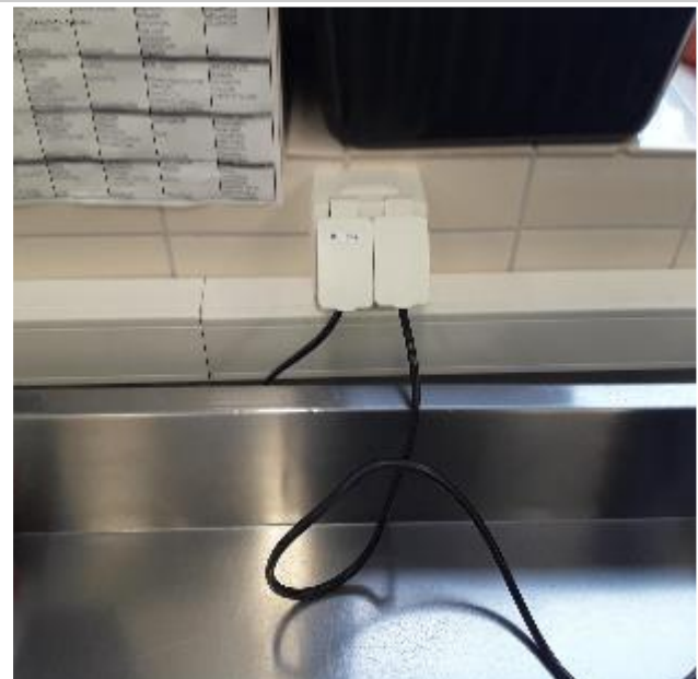
Keittiötiloissa on käytetty johtokanavia mm. pistorasioille.
