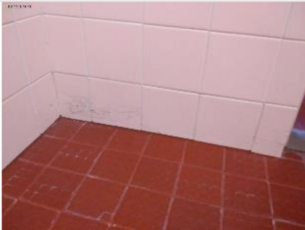
Märkätiloissa seinälaatoituksia on rikki.
