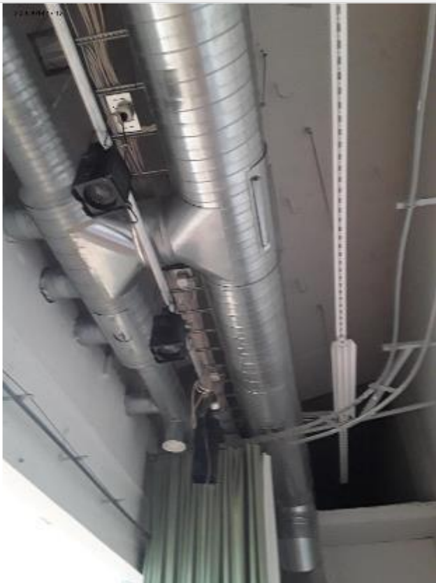
Näyttämön valaisimille on asennettu ripustuskojo. Ripustuskojoet ovat hyvässä kunnossa.
