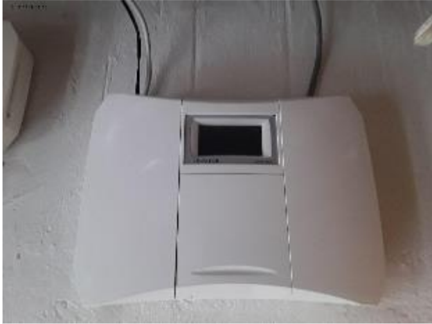
Ovikoodijärjestelmän ohjauskeskus on asennettu lohkon 2 sisääntulokäytävällä.
