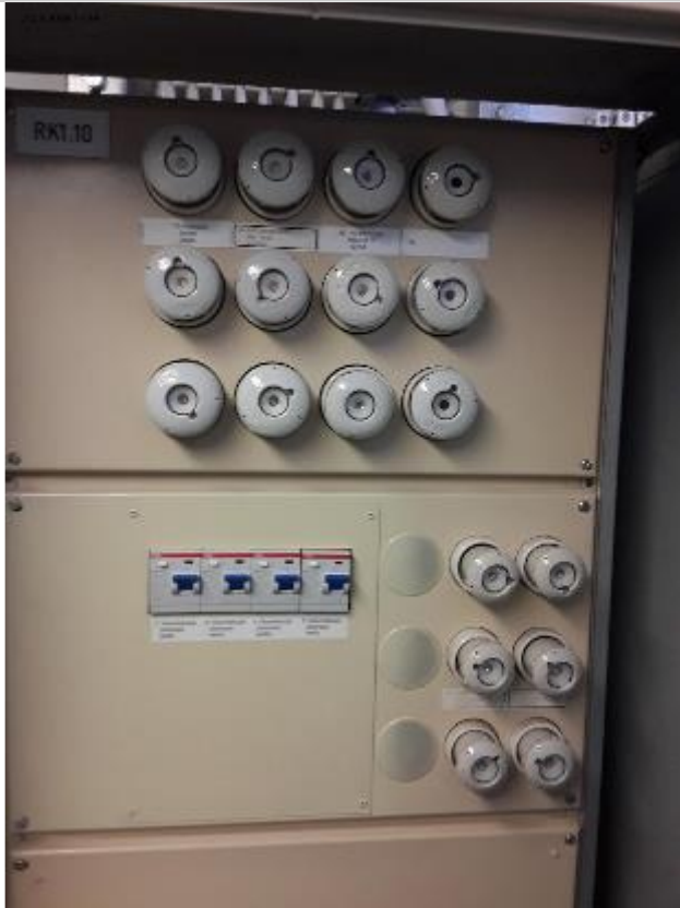
Keittiölaitteiden keskus. Keskukseen on asennettu vikavirtasuojaukset.
