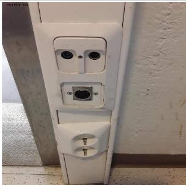
Johtokanava on uusimisen tarpeessa.
