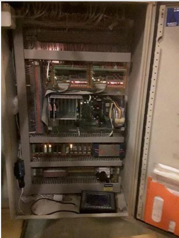
Kiinteistön automaatiojärjestelmä pitää sisällään 4kpl valvonta-alakeskuksia.
