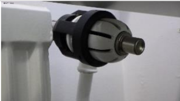
Yleiskuva termostaattisesta patteriventtiilistä
