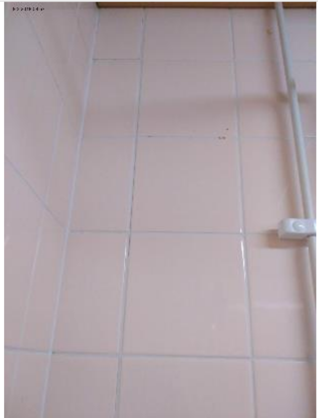
Märkätiloissa laattasaumoissa on halkeamia ja laatoitus on irti alustastaan laajoilla alueilla
