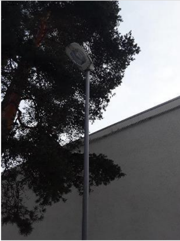
Pylväsvalaisinten monimetallilamput suositellaan uusittavaksi LED-lampuiksi ja pylväiden sekä johtojen uusiminen tulee ajankohtaiseksi lähitulevaisuudessa.
