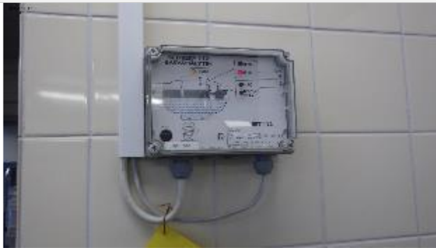
Rasvanerotuskaivon täyttymishälyttimessä palaa häiriö valo.
