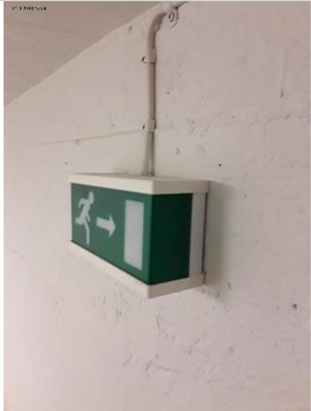
Poistumistievalaisin on palanut. Valaisimen lamppu on vaihdettava tai valaisin on uusittava.
