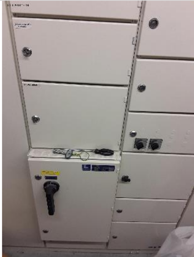
Pääkeskus on uusittu v.1996 ja pääkeskus on hyvässä kunnossa.
