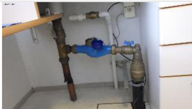
Kiinteistön päävesimittari ja pääsulut sijaitsevat opettajien huoneessa.
