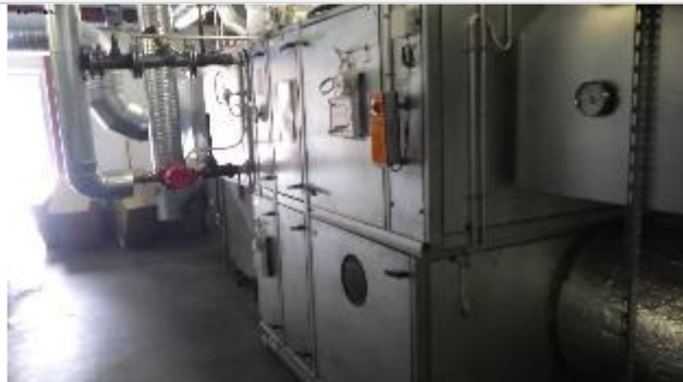
Yleiskuva tulo- /poistoilmakoneesta TKPK04, joka palvelee osan 2A liikuntatiloja.
