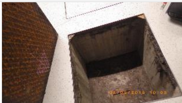
Alapohjan huoltoluukut eivät ole kaasutiiviitä.
