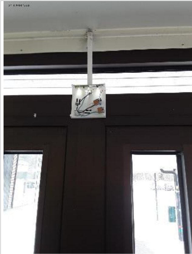
Kiinteistön poistumistievalaisimet ovat todella heikossa kunnossa. Valaisimet ovat uusittava välittömästi.
