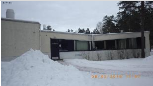
Yleiskuva julkisivusta ja ulkoseinästä, jossa eristetilä lähtee arviolta ulko-oven alakarmin alapuolelta
