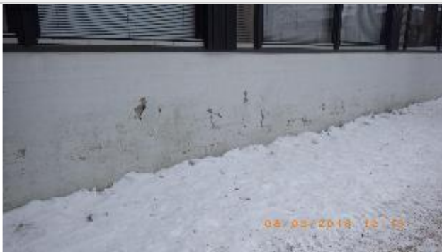
Yleiskuva sokkelista/ulkoseinärakenteesta jossa on pintavaurioita ja halkeamia.
