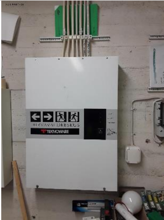
Teknowaren laitteisto on asennettu v.2002-2003 tienoilla.
