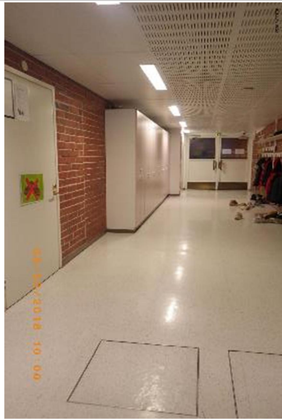
Yleiskuvaa sisätiloista. Lattioissa on tarkastusluukkuja.
