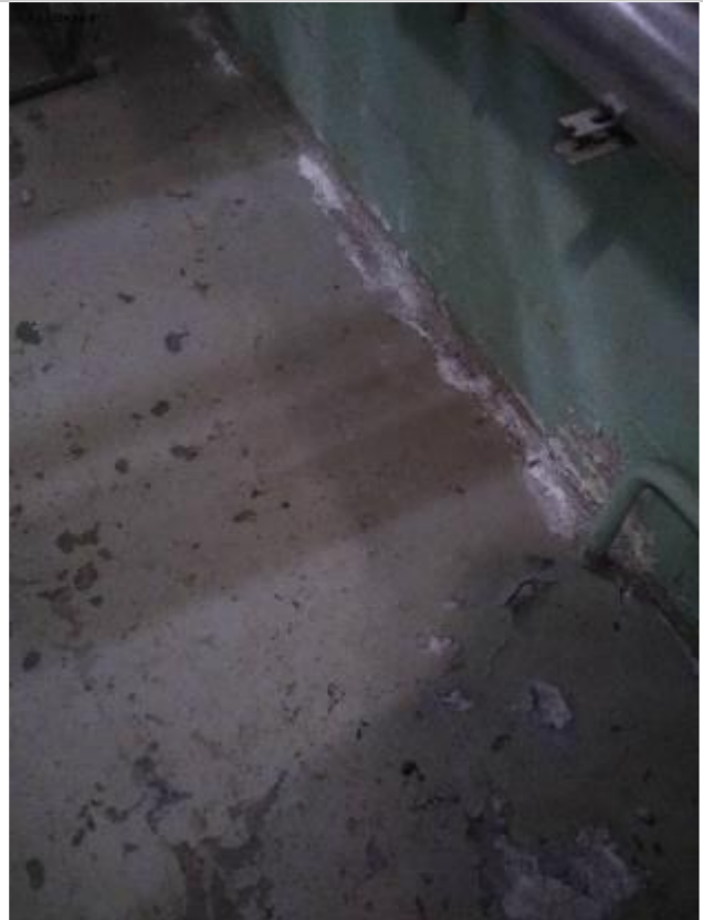
Kellarin kiviainesrakenteisissa seinissä näkyy härmää ja pinnoitteen irtoamista.
