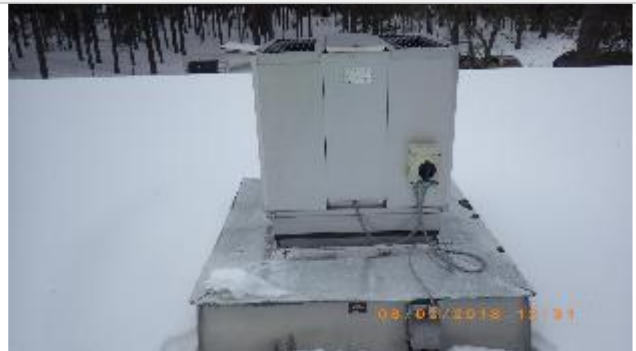
Yleiskuva kotitalousluokkia palvelevasta huippuimurista PK3, valmistaja on FläktWoods ja valmistusvuosi 2013.
