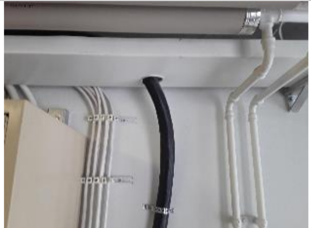
Yleisten tilojen näkyvillä osilla on käytetty levyhyllyjä. Hyllyt ovat hyvässä kunnossa.
