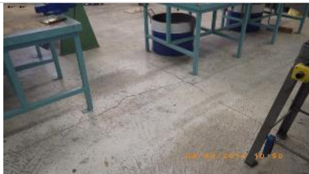
Teknisen käsityön luokassa lattian betonilaatassa on rakenteellisia halkeamia.
