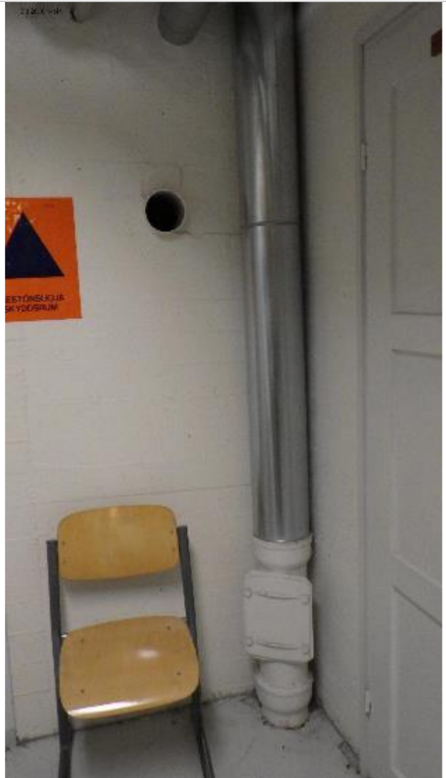
Koulun sisäpuoliset sadevesiviemärit on eristetty.
