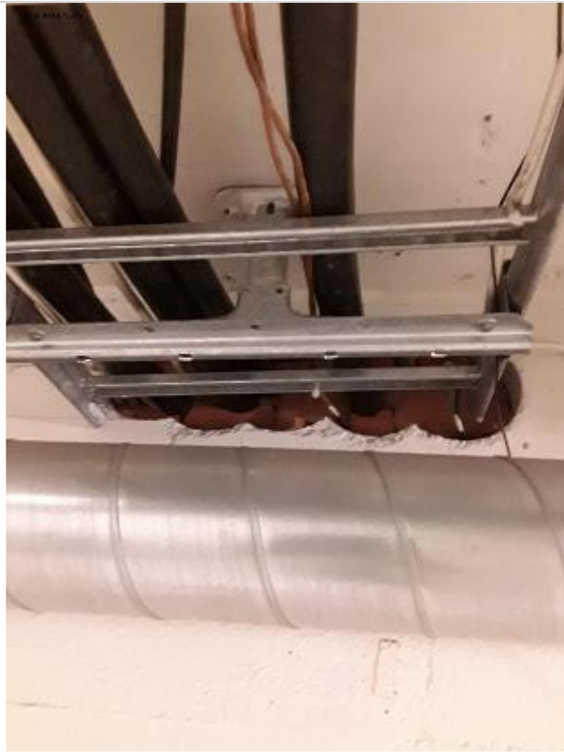
Läpiviennit on palomassattu.
