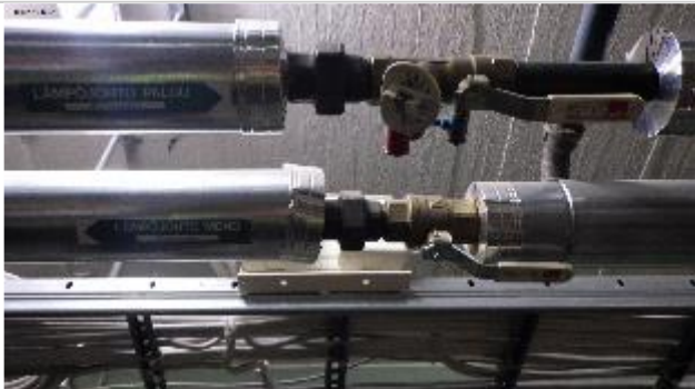
Yleiskuva lämpöjohtoverkoston sulku- ja säätöventtiileistä
