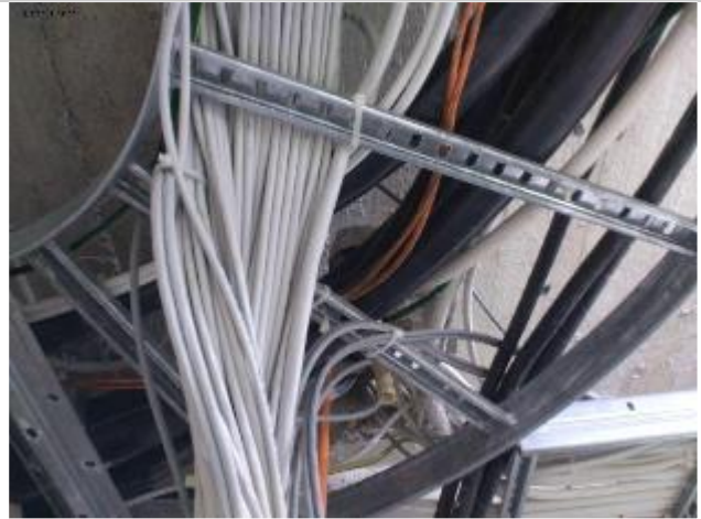
Läpivientien palokatkot ovat puutteellisia ja korjattava heti
