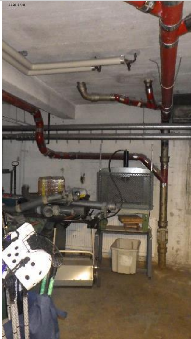
Koulun jätevesiviemäreitä on korjattu tarpeen mukaan.
