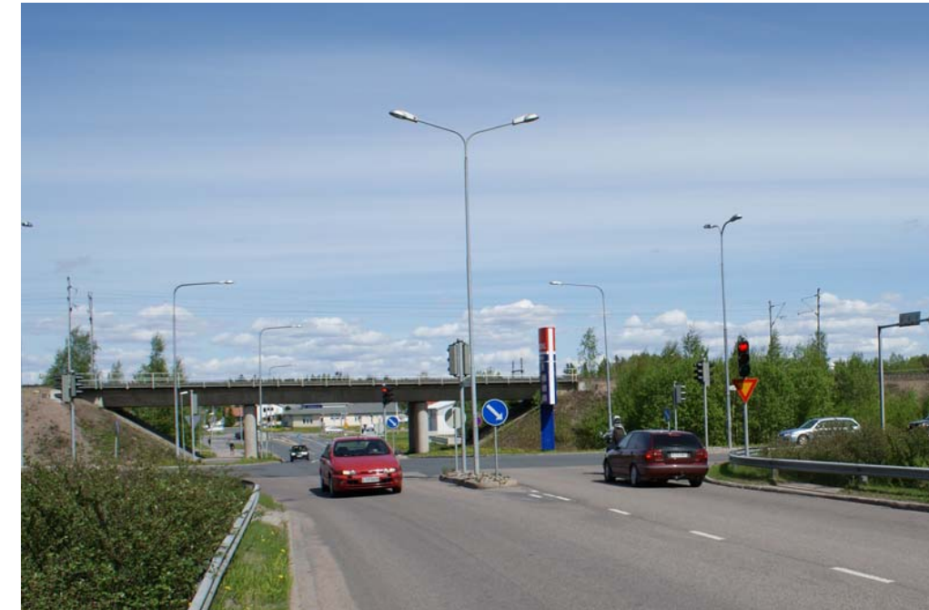
Kuva 35. Eteläisen kehäkadun ja Jokelankadun liittymä.
