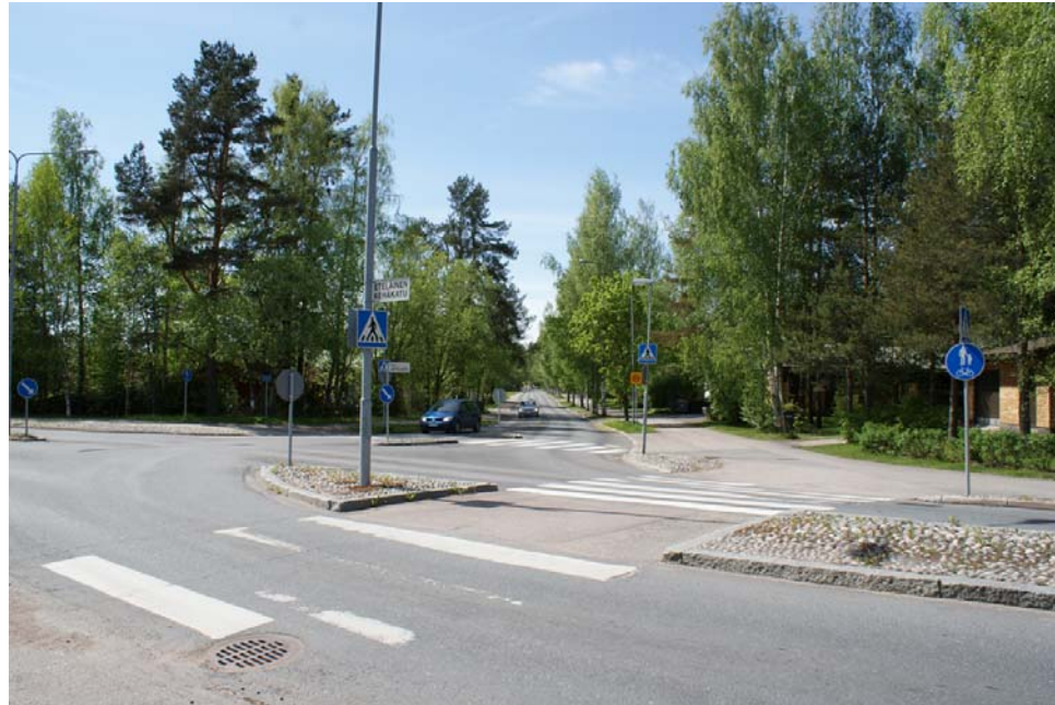
Kuva 24. Eteläisen kehäkadun ja Yli-Anttilantien liittymä. Liittymän pääsuunta on epäselvä.
