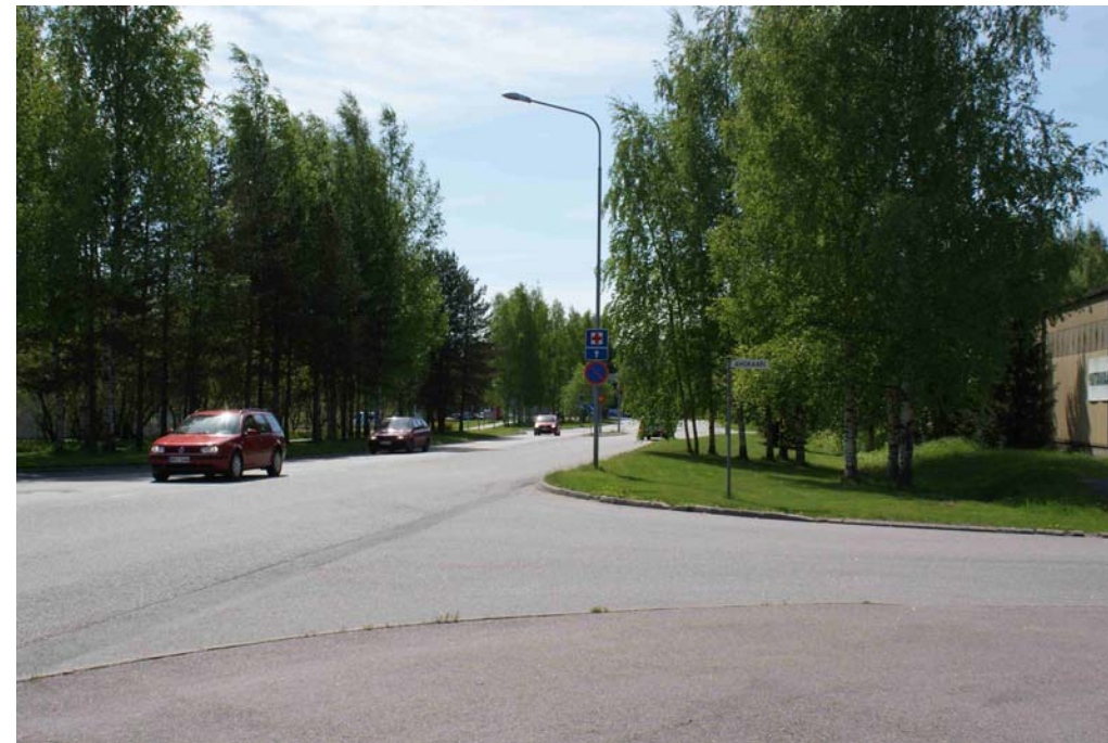
Kuva 26. Ahokaaren ja Vehkatien väliltä Eteläisen kehäkadun pohjoispuolelta puuttuu kevyen liikenteen yhteys.
