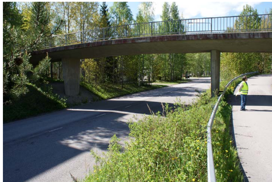
Kuva 3. Eteläisen kehäkadun kevyen liikenteen ylikulkusilta Hakalassa.
