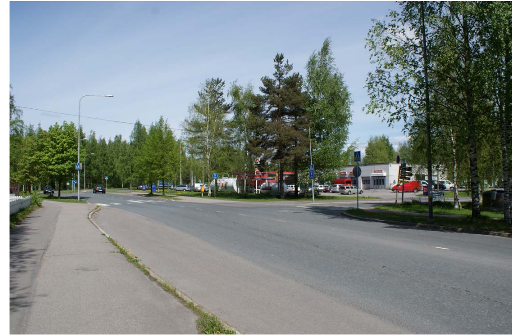
Kuva 25. Eteläisen kehäkadun ja Kehäkadun liittymä.
