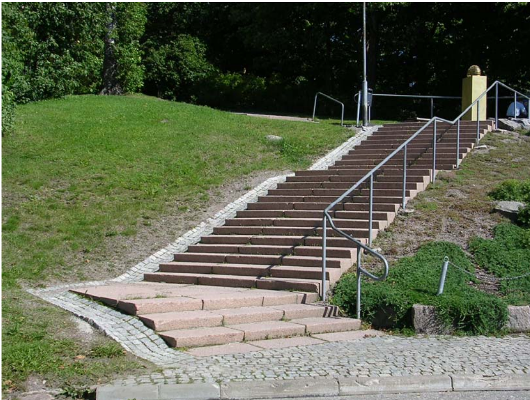
Kuva 25. Kirkkopuistoon johtaviin portaisiin tarvitaan oikeaoppiset käsijohteet molemmin puolin sekä ylätasanteelle selkä- ja käsinojallinen penkki.
