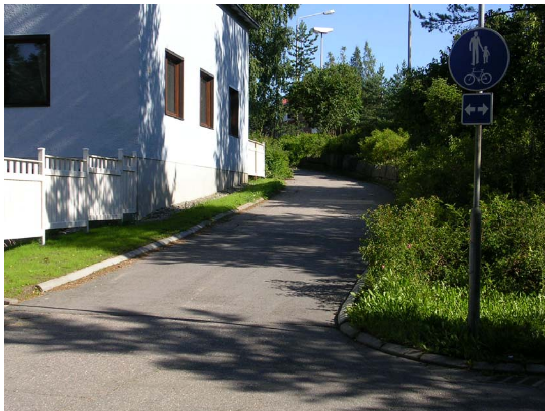
Kuva 44. Läntisen Yhdistien alikulkuun laskeviin luiskiin tulisi lisätä käsijohteet.
