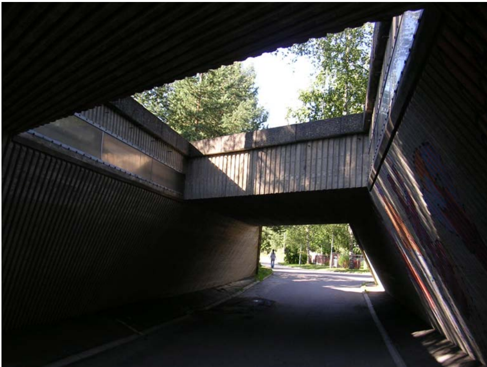
Kuva 30. Läntisen Yhdystien alikulun viihtyisyyttä lisää ajoratojen väliin sijoitettu valoaukko.
