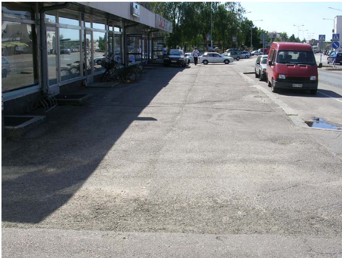
Kuva 40. Uudistetun Hämeenkadun osuuden itäpuolella on vaarallisen epätasaiseksi painuneita jalkakäytäväjaksoja, jotka tulisi kiireellisesti paikata.
