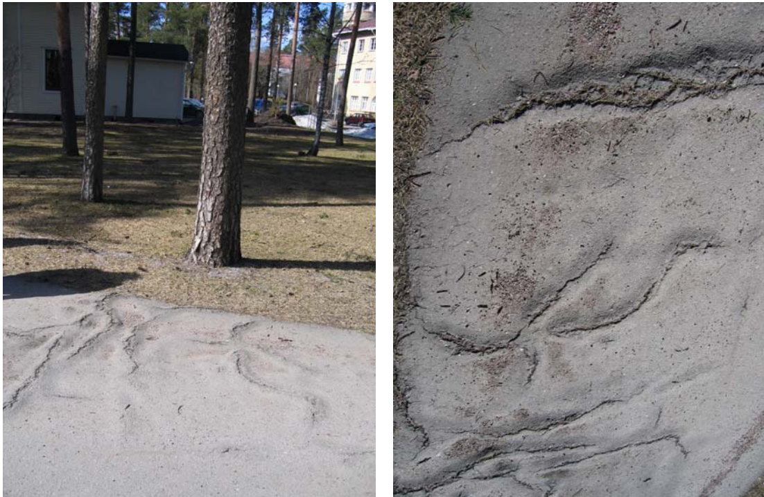
Kuva 5. Mäntyjen voimakkaat juuret ovat rikkoneet kävelytien asfalttipintaa.
