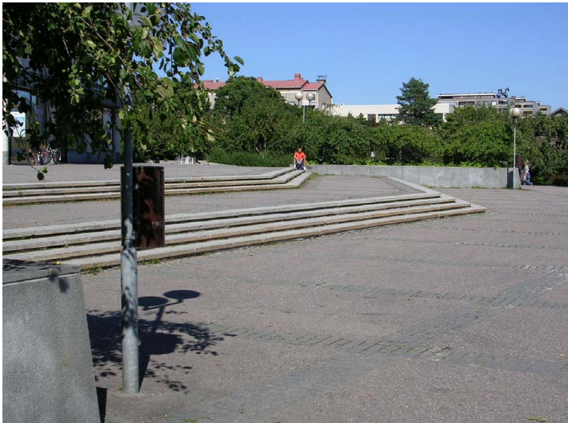
Kuva 26. Keskuskorttelissa on useita portaita ja jyrkkiä luiskia, joissa ei ole käsijohteita. Roskakori tulisi laskea alemmaksi niin, että sen suuaukko on n. 1,1 metrin korkeudella.
